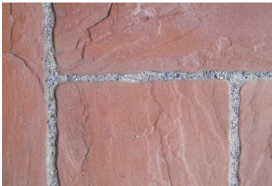
Verfugen mit Sand
