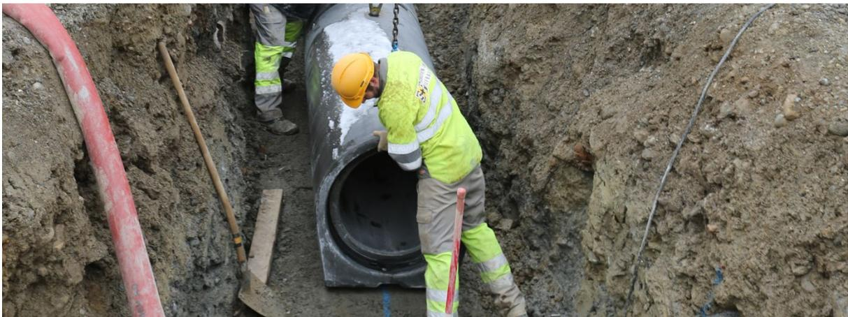
Bild 45: Nach dem Zusammenschieben der Rohre ist die Lage zu kontrollieren
