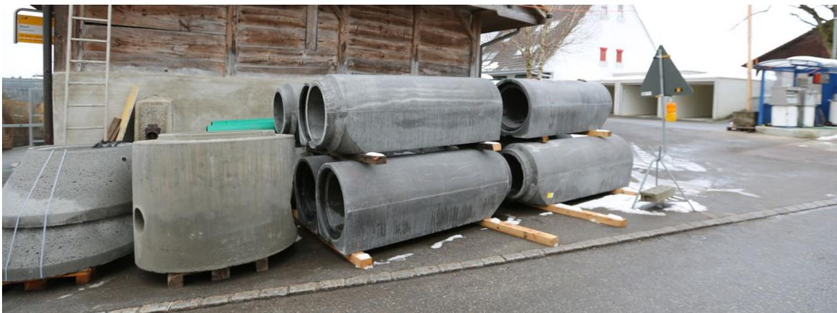
**Bild 15:** Einfache, sichere Lagerung, vor Sonneneinstrahlung geschützt
