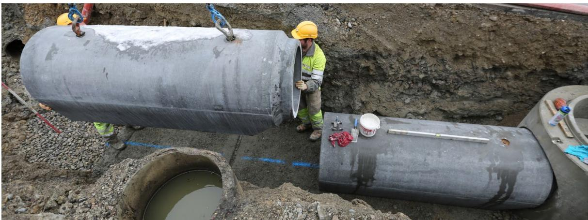
**Bild 49: Anschluss an ein vorfabriziertes CENTUB® Schachtunterteil**
