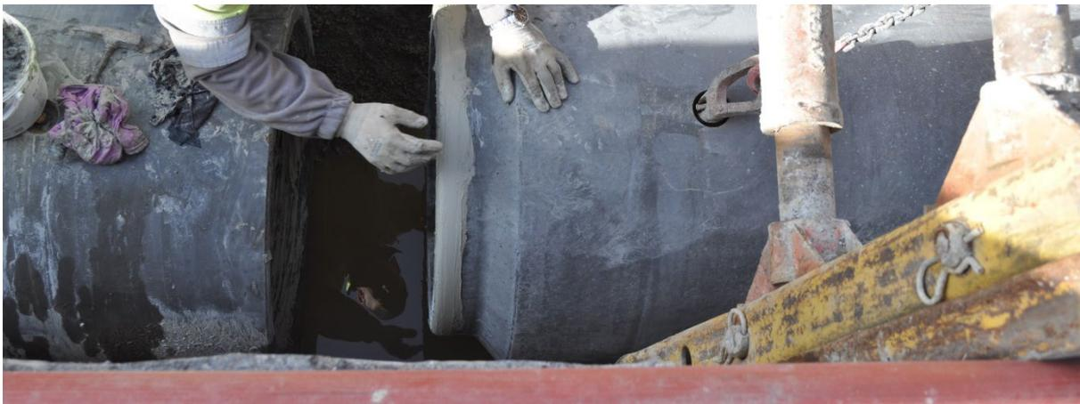
Bild 38: Aufbringen des DENSÖ® Gleitmittel erst kurz vor dem Zusammenschieben
