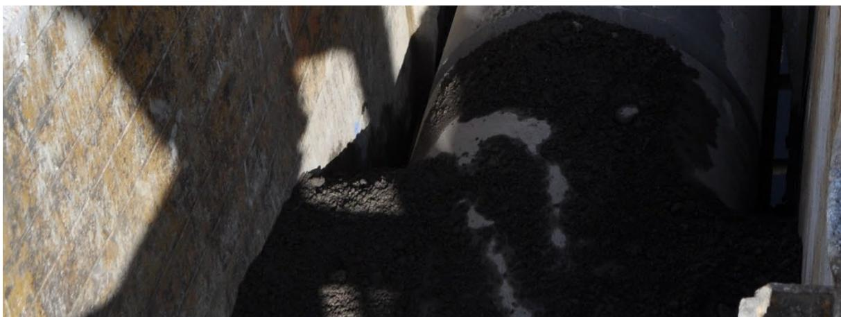
**Bild 55: Lagenweises Einbringen der seitlichen Verfüllung nach der Verlegung, keine Wartezeiten infolge Aushärtungszeit**
