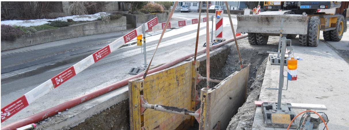
Bild 58: Schrittweiser Rückbau des Verbaus
