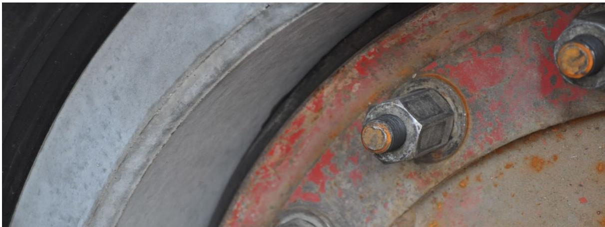
Bild 61: Eingebauter Absperrendeckel während einer Dichtheitsprüfung
