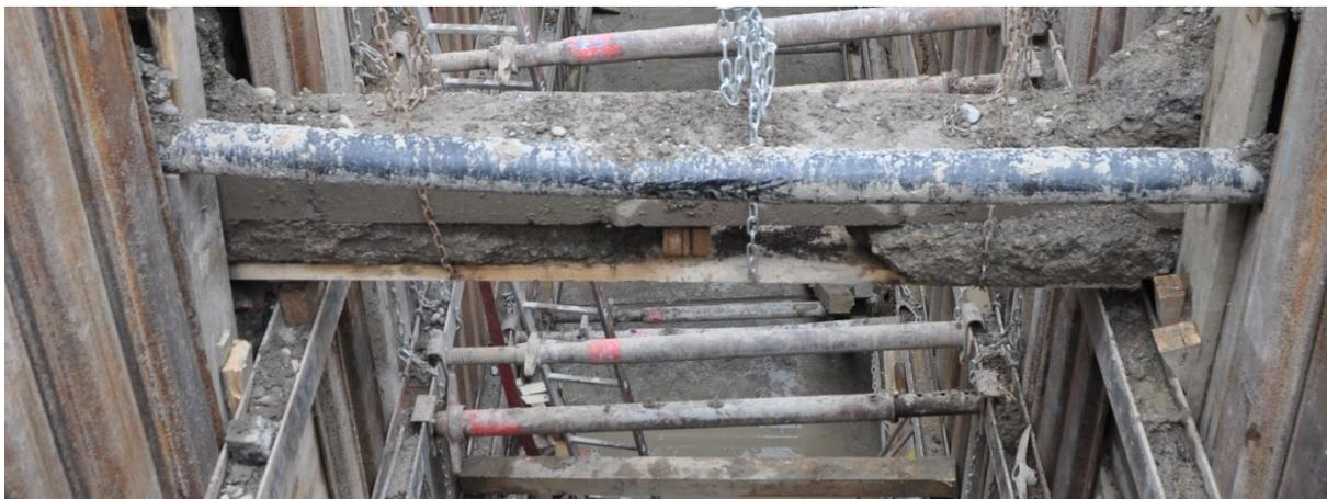
Bild 18: In städtischer Umgebung ist die Grabensicherung von der Grabentiefe und deren Breite, wie auch von der Anzahl Werkleitungen abhängig
