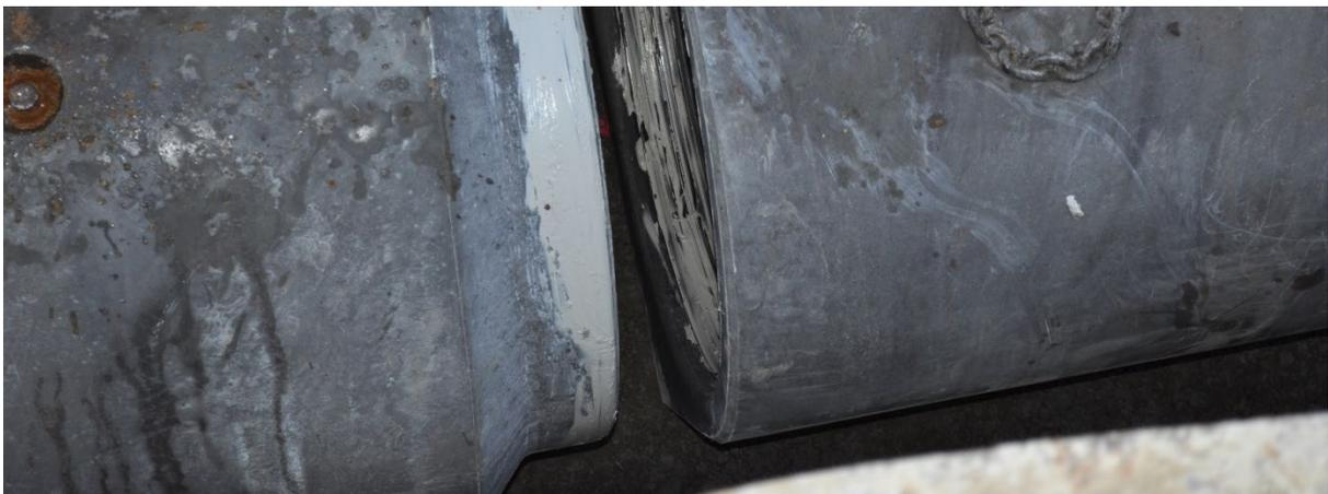
Bild 35: Verlegung von MAROWA® Hochleistungsbetonrohren auf einer Frischmörtelschicht
