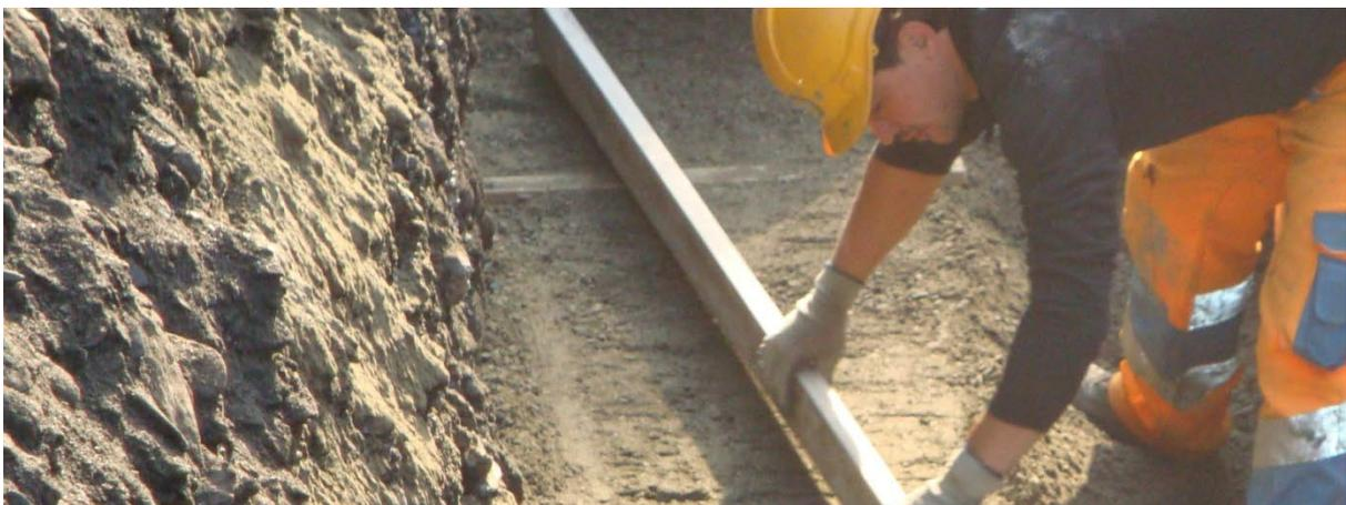
**Bild 32:** Bei Rohren mit Fuss ist eine gleichmäßige, vollflächige Auflagerung erforderlich
