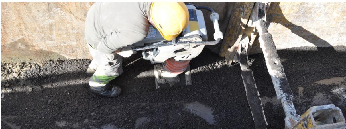
Bild 54: Seitliche Verfüllung und deren Verdichtung von Recyclingmaterial sofort nach Einbau der Rohre
