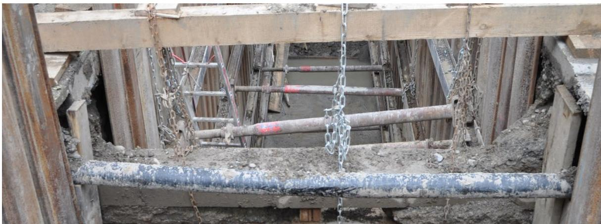
**Bild 2:** Werkleitungen müssen sondiert und während den Bauarbeiten entsprechend geschützt werden
