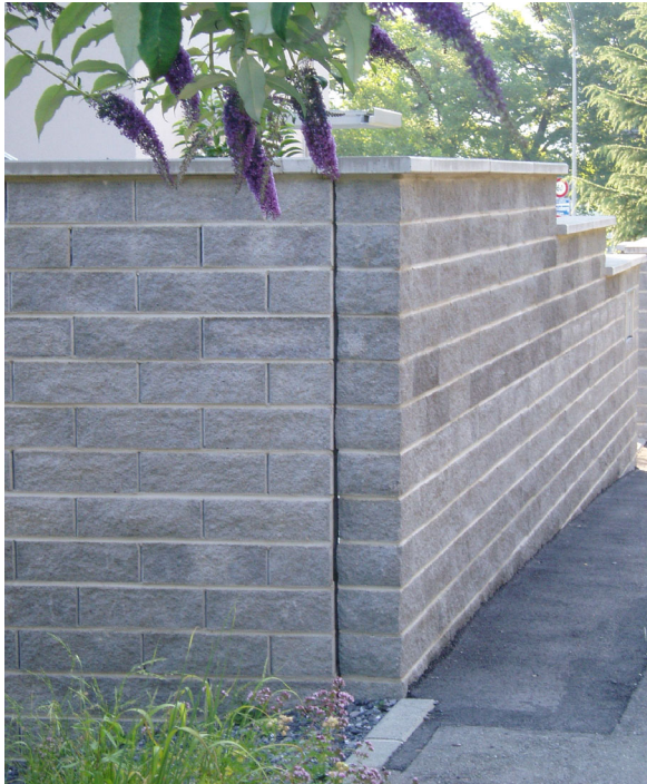
Bild 15: Dilatationsfuge (Produktneutral)
