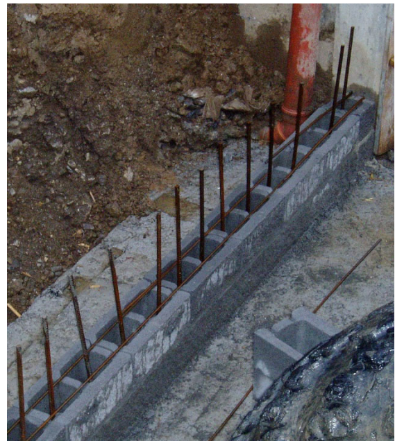
Bild 11: Horizontale und vertikale Bewehrung (Produktneutral)
