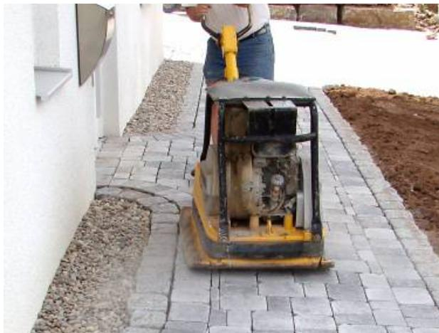
Bild 36: Abrütteln der Pflasterfläche
