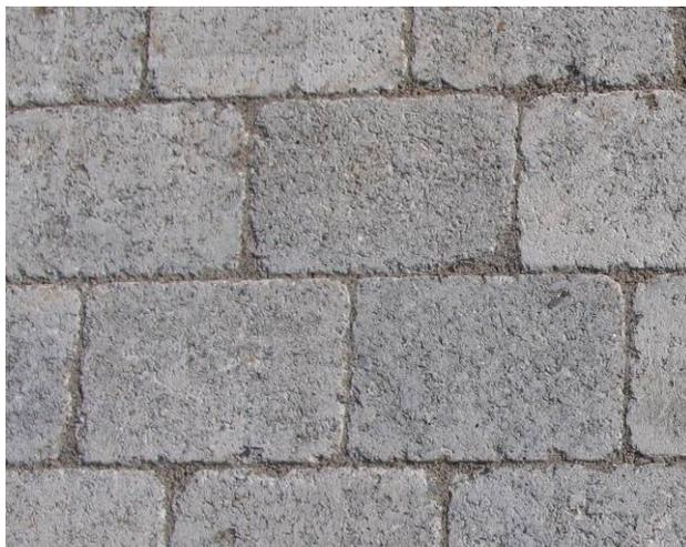
Bild 34: Optimale Fugen bei TEGULA® Pflastersteinen
