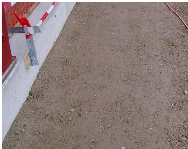
Bild 32: Eingebaute verdichtete Fundationsschicht
