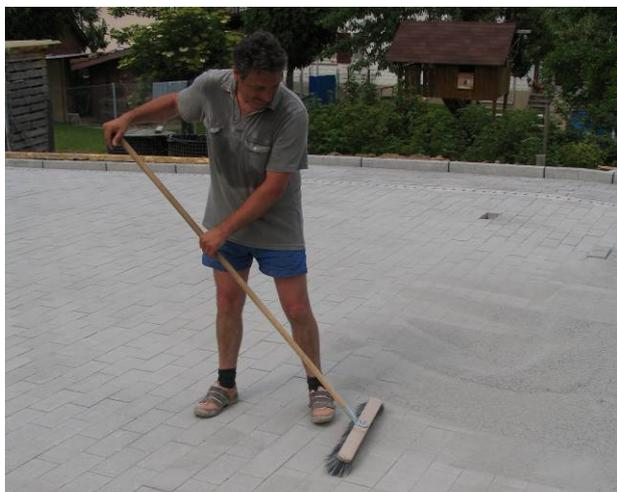
Bild 37: Einsanden der Fugen
