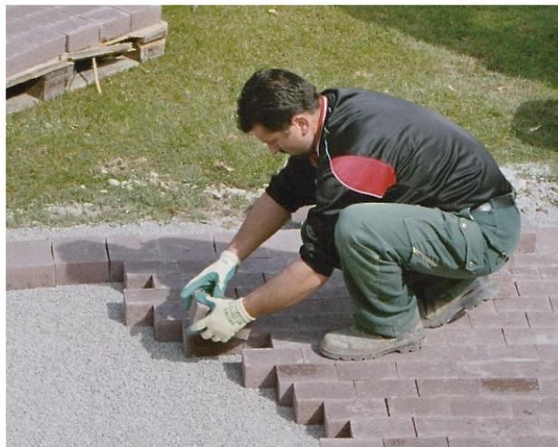
Bild 35: Verlegung der Steine von Hand
