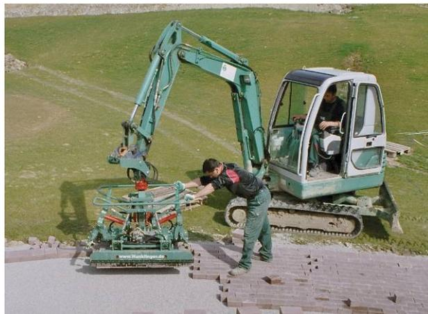
Bild 38: Verlegemaschine im Einsatz
