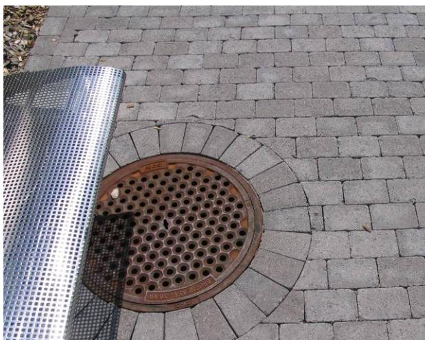
Bild 42: Anpassung bei Schachtabdeckung
