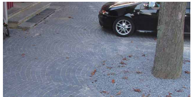
Anpassung bei einer Baumöffnung
