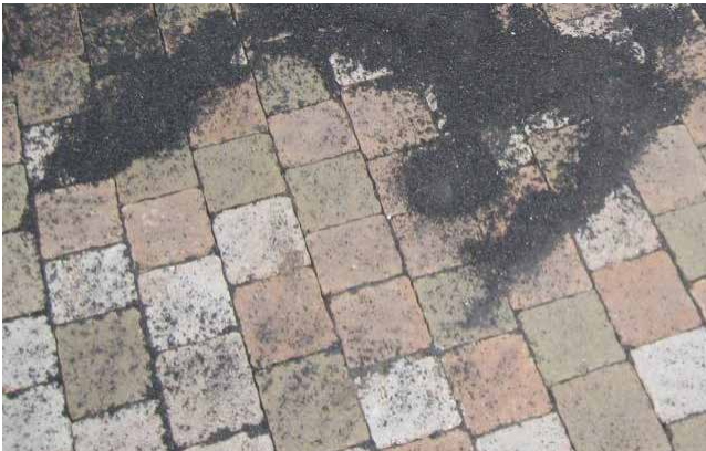
Einsanden der Fugen
