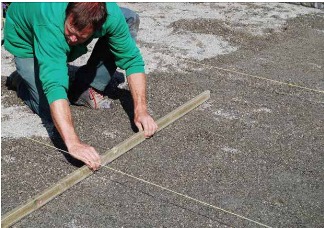
Abziehen der Bettungsschicht
