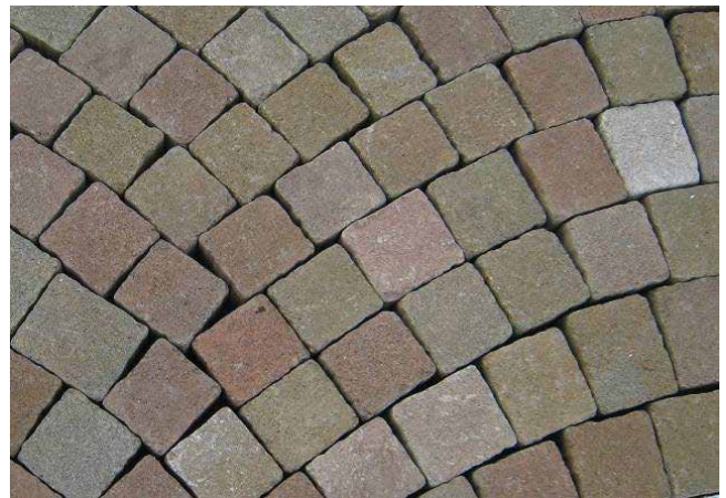
Verlegte FRIEDA® Pflastersteine für eine Segmentpflasterung
