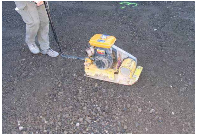
Verdichten der Fundationsschicht
