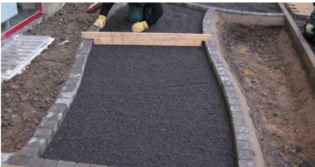
Betonierter Randabschluss
