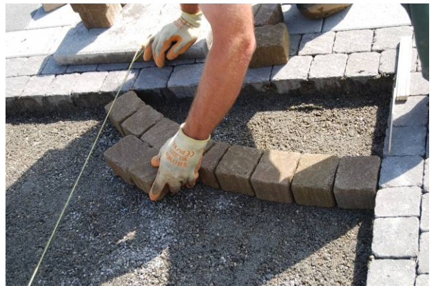
Bild 29: FRIEDA® Pflastersteine werden von Hand verlegt
