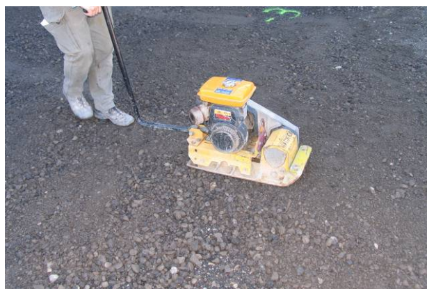
Bild 26: Verdichten der Foundationsschicht
