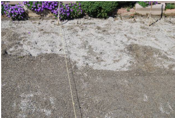
Bild 28: Richtschnur als Richtungshilfe oder für den Rasteraufbau
