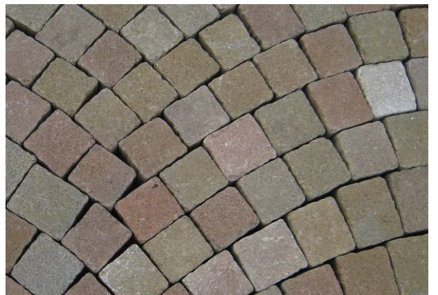
Bild 30: Verlegte FRIEDA® Pflastersteine für eine Segmentpflasterung
