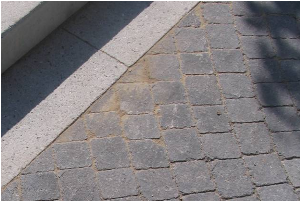
Bild 34: Pflasterfläche mit Passteinen
