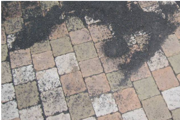
Bild 31: Einsanden der Fugen
