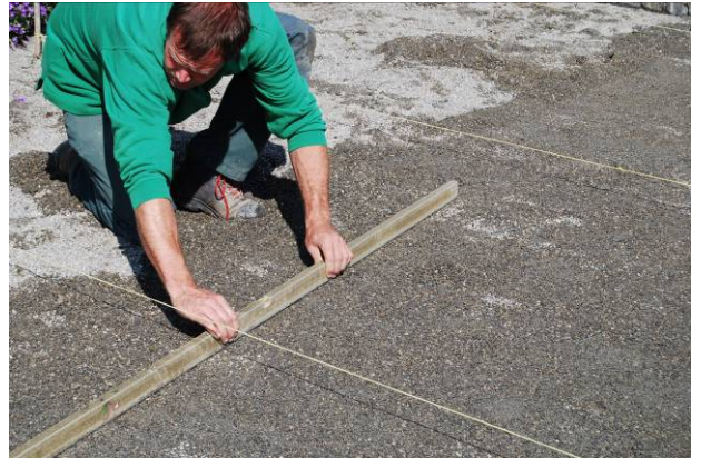
Bild 27: Abziehen der Bettungsschicht
