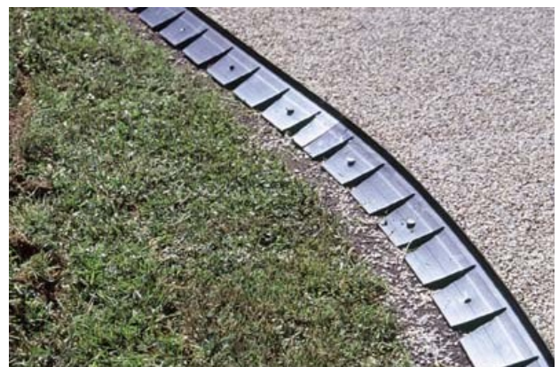
Bild 38: Randabschluss mit PAVE EDGE Randschienen
