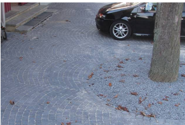
Bild 36: Anpassung bei einer Baumöffnung
