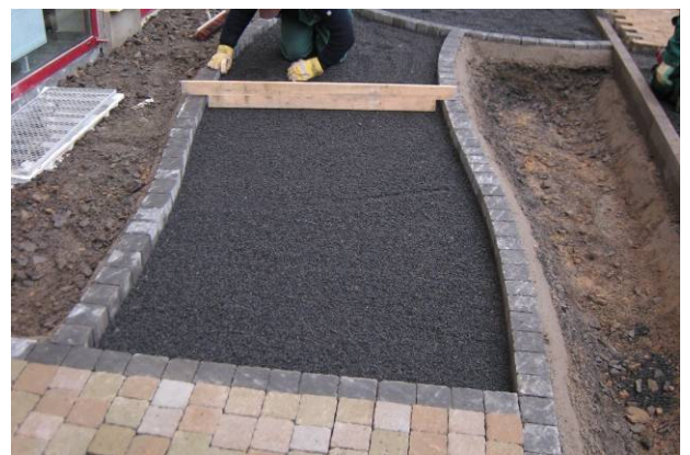
Bild 37: Betonierter Randabschluss
