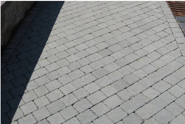
Bild 35: Pflasterfläche mit Passteinen bei Randabschluss
