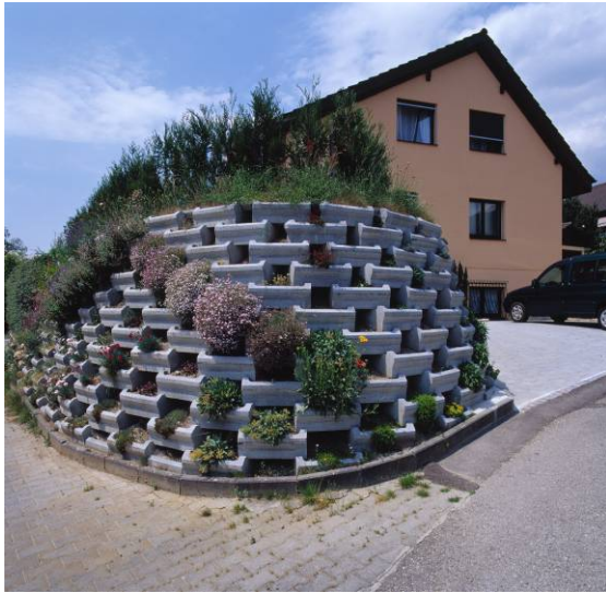
Bild 29: VERDURO® als Lärmschutzmauer
