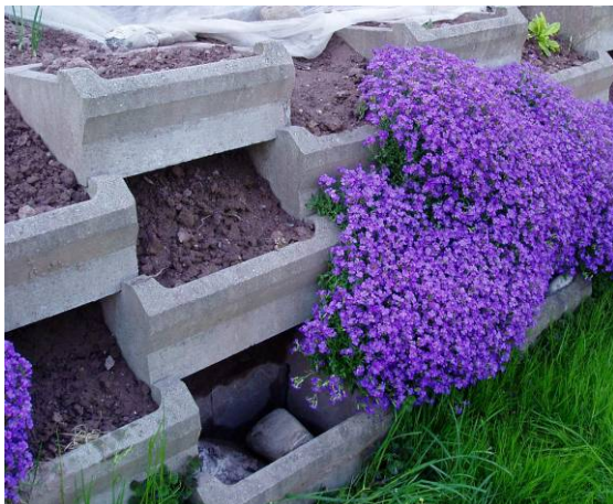
Bild 15: Seitenwände übereinander versetzt
