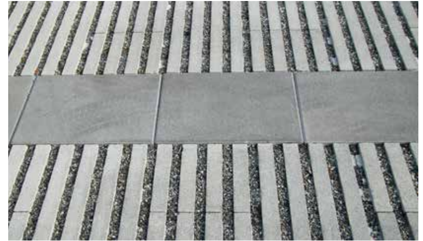
Schrittplatten mit Nocken in Kombination mit RAINA Rasenliner verlegt
