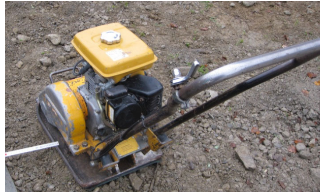
Bild 39: Verdichten nur mit leichten Verdichtungsgeräten
