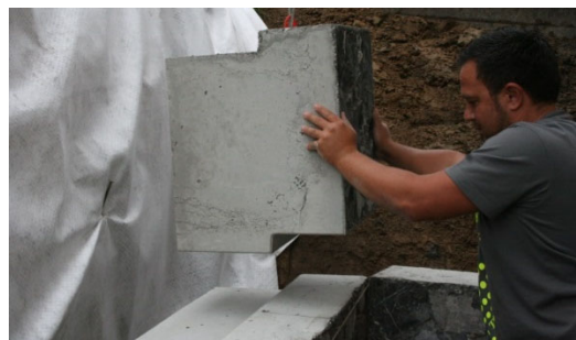
Bild 34: Versetzen der weiteren Elemente
