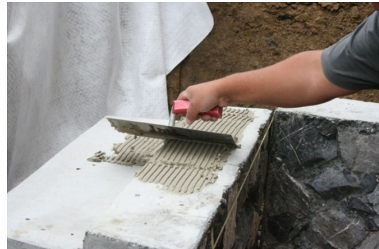
Bild 35: Auftragen des Klebemörtels
