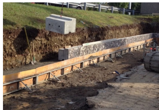
Bild 27: Erstellen des Streifenfundamentes
