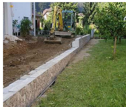
Bild 38: Lagenweises Einbringen von geeignetem Hinterfüllmaterial
