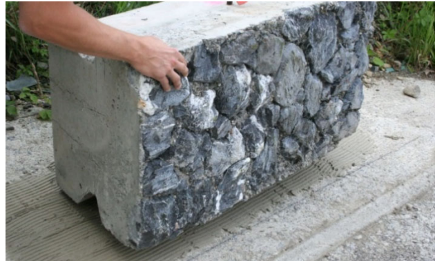
Bild 31: Streifenfundament mit Klebemörteldünnschicht
