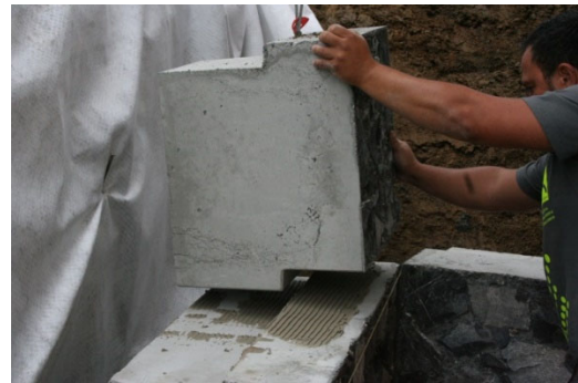
Bild 36: Versetzen der weiteren Elemente in Klebemörtel
