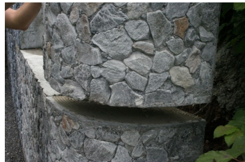
Bild 37: Versetzen eines Eckelementes
