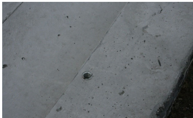
Bild 24: Werkseitig eingebaute Transporthülsen M16
