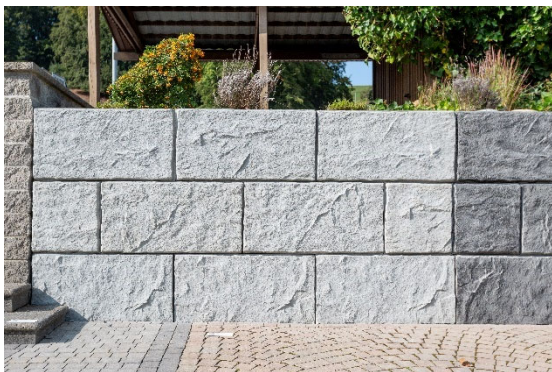
Bild 1: FELSMAUER Böschungselemente als Böschungssicherung
