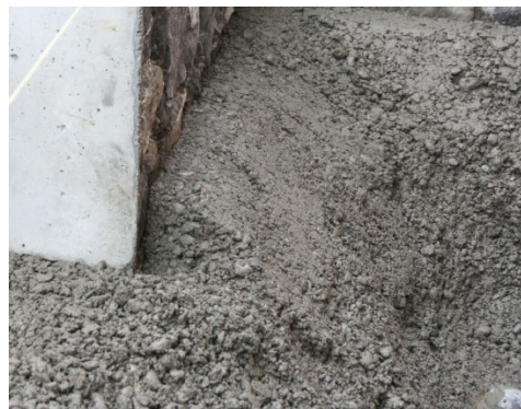
Bild 32: Erstellen des Fundamentnocken
