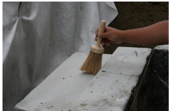
Bild 33: Verschmutzungen auf Auflageflächen entfernen
