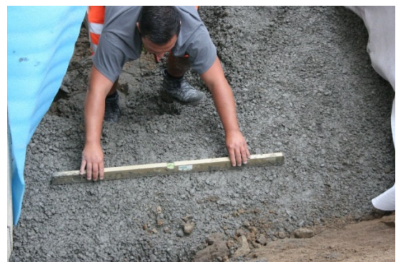
Bild 26: Erstellen der Sauberkeitsschicht
