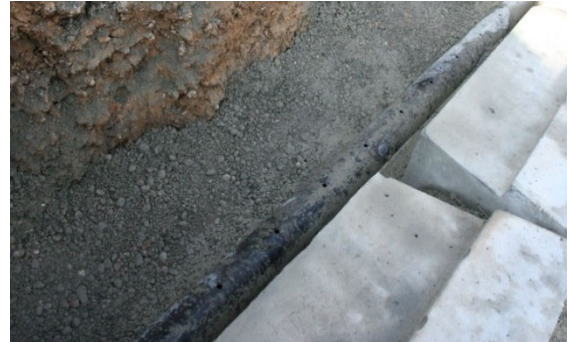
Bild 28: Einbau einer Sickerleitung
