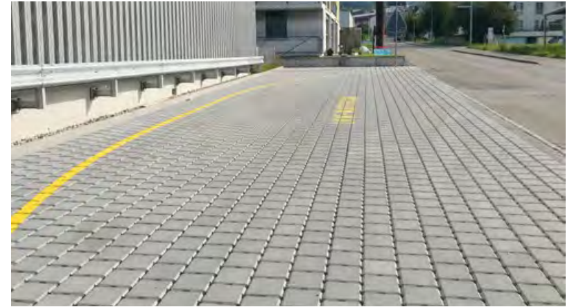
VS 5 ® Schwerlastökosteine mit fünffacher Verschiebesicherung, Farbe Grau – englisch verlegt
