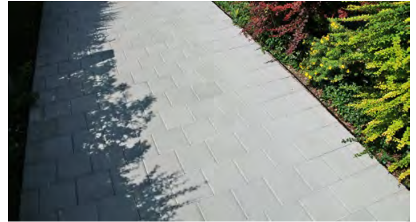
CARENA® Pflastersteine, Farbe Grau – englisch verlegt
