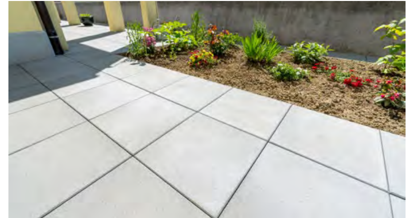
ESTRELLA fino Gehwegplatten, Farbe Grau-Anthrazit – Kreuzfuger verlegt
