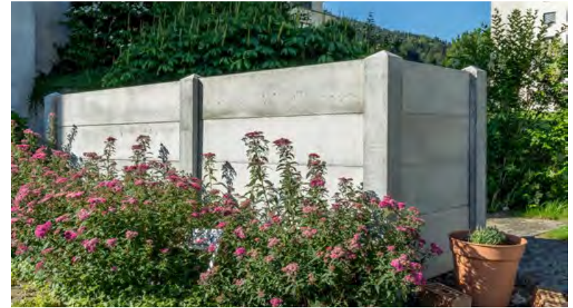
Pfosten zu Betonbretter dienen zusammen mit den Betonbrettern vollkändig als Containereinfassung, Farbe Grau
