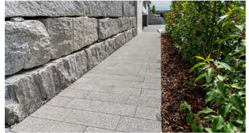
RAINA Sickersteine fino, Farbe Grau – englisch verlegt
