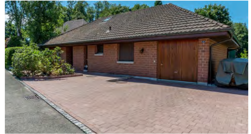
CLASSIC® Pflastersteine, Farbe Erdbraun – englisch verlegt
