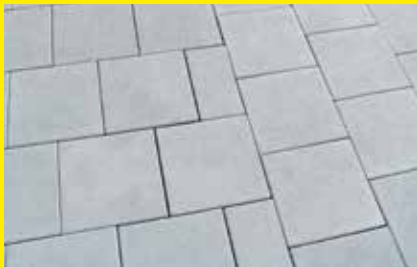
Richtungswechsel der Pflastersteine
