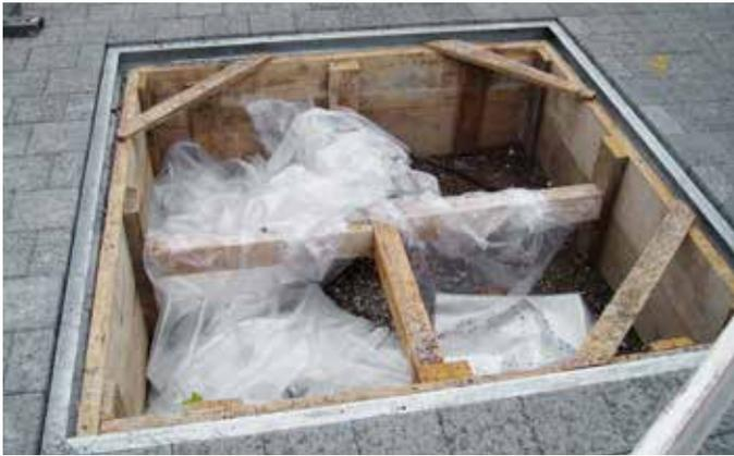
Eingebauter Stahlrahmen als Baumkranz
