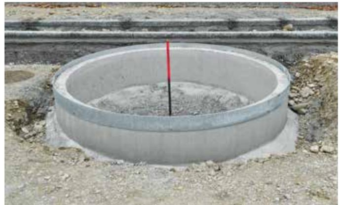
Montierter Stahlleinbaurahmen mit Bolzenanker
