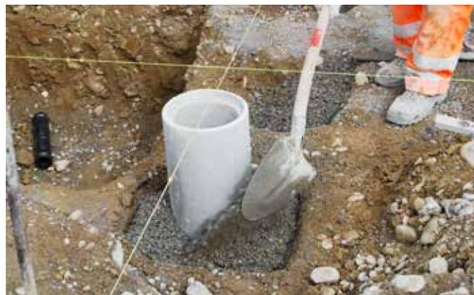
Erstellen der Punktaulager mit Betonrohren
