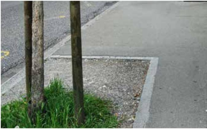
**Ungeschützter Wurzelraum führt zu hoher Bodenverdichtung**
