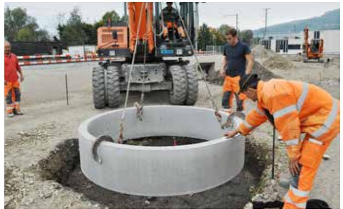
Versetzen des TREETUB Betonrohres auf das Streifenfundament
