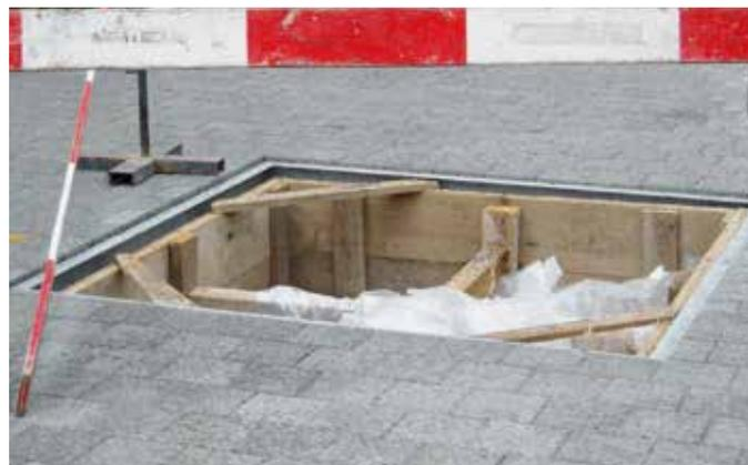
**Pflanzgrube mit Fundament und Stahlrahmen**
