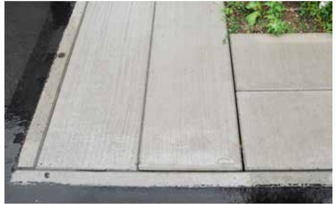
Wasserzufuhr durch Fugen
