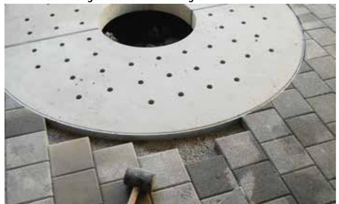
Versetzte TREETUB Betonabdeckung 2-teilig
