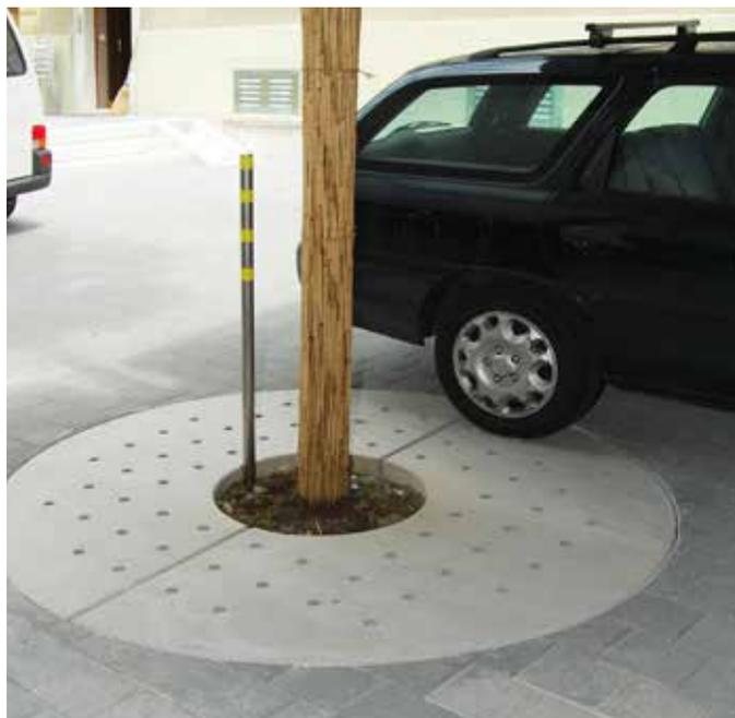
TREETUB Baumwurzelraumschutz mit Betonabdeckung
