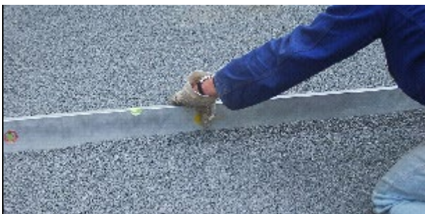
Bild 7: Bettungsschicht abziehen
