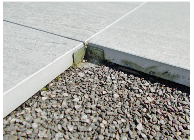
Bild 8: Verlegen der Feinsteinzeug Gehwegplatten in Bettungsschicht
