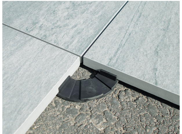
Bild 12: Verlegen der Feinsteinzeug Gehwegplatten auf Lagerringe
