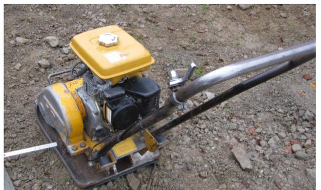
Bild 42: Verdichten nur mit sehr leichten Verdichtungsgeräten
