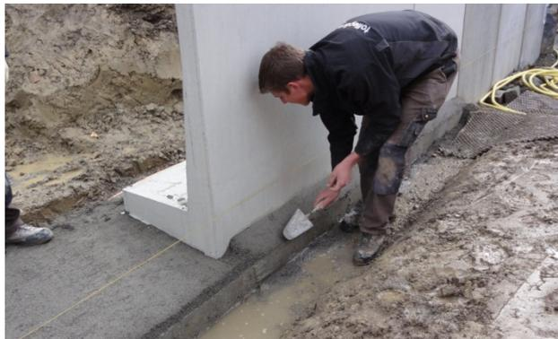
Bild 37: Erstellen der Fundamentnocken
