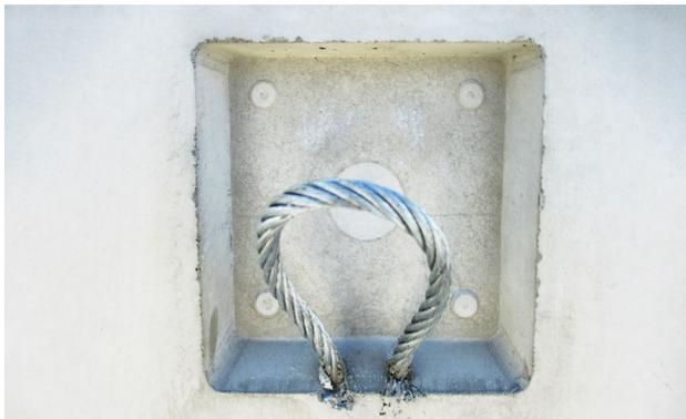
**Bild 30: Werkseitig eingebaute Seilschlaufen**
