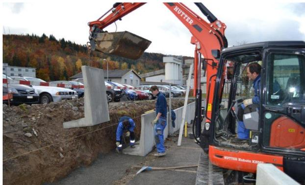
Bild 35: Versetzen der Winkelplatten
