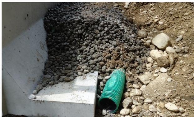
Bild 34: Einbau einer Sickerleitung
