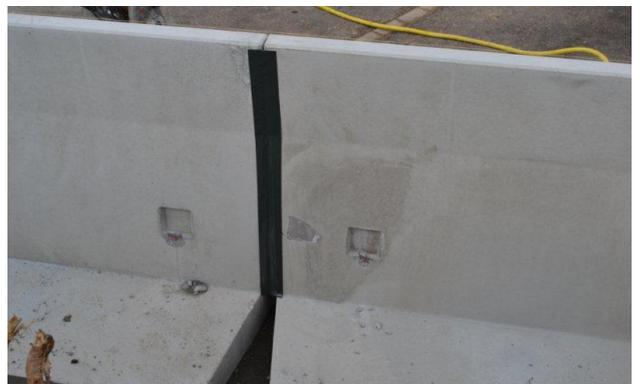
Bild 40: Abdichten der Fugen
