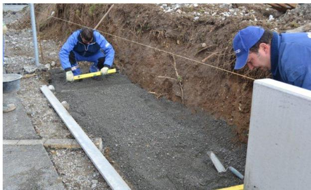
Bild 33: Erstellen des Streifenfundamentes
