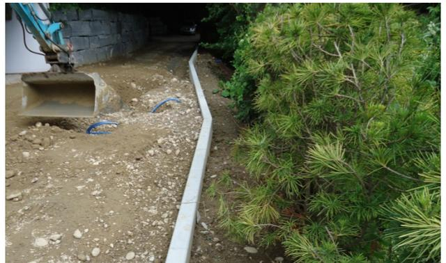
Bild 41: Lagenweises Einbringen von geeigneten Hinterfüllmaterial
