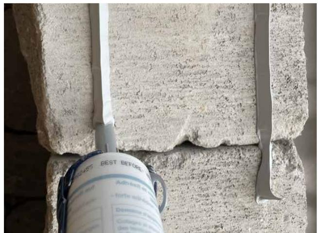
Bild 3: Korrekte Ausrichtung der Düse
