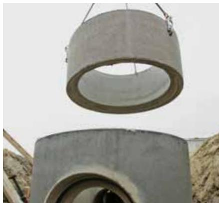
Der Schachtaufbau besteht aus Schachtringen und -kone. Für geringe Schachttiefen werden anstelle von Kone bewehrte Abdeckplatten eingesetzt. Je nach Anordnung des Unterteils (längs- oder quergestellt) sind die entsprechenden Bauteile zu wählen.
