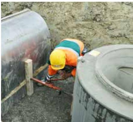
Die Schachtunterteile werden auf einer höhengerechten und horizontalen Sohle einfach und rationell versetzt. Je nach Wahl des Rohrmaterials müssen vorgängig entsprechende Pass- oder Gelenkrohre bzw. bei biegeweichen Rohren ein abgelängtes Rohr auslaufseitig versetzt werden.
