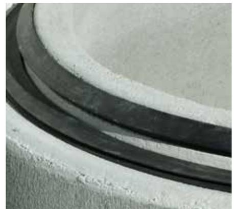
Die wasserdichten Muffenverbindungen bestehen aus elastomeren, losen Keilgleitdichtungen. Dadurch wird die Wasserdichtheit über Jahre garantiert. Für Schächte mit grossen Tiefen (> 5 m) werden Lastausgleichsringe empfohlen.
