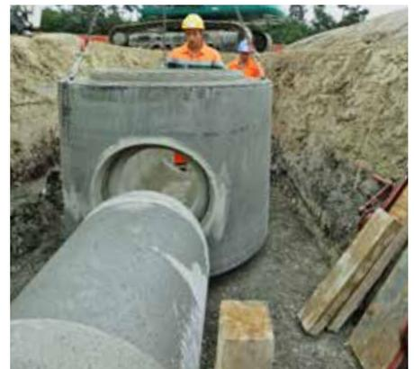
Mit den werkseitig eingebauten Kugelkopftragankern und dem entsprechenden Gehänge können die Schachtaufbauteile schnell und sicher auf der Baustelle transportiert und eingebaut werden. Das Risiko für das Personal auf der Baustelle wird dadurch minimiert.
