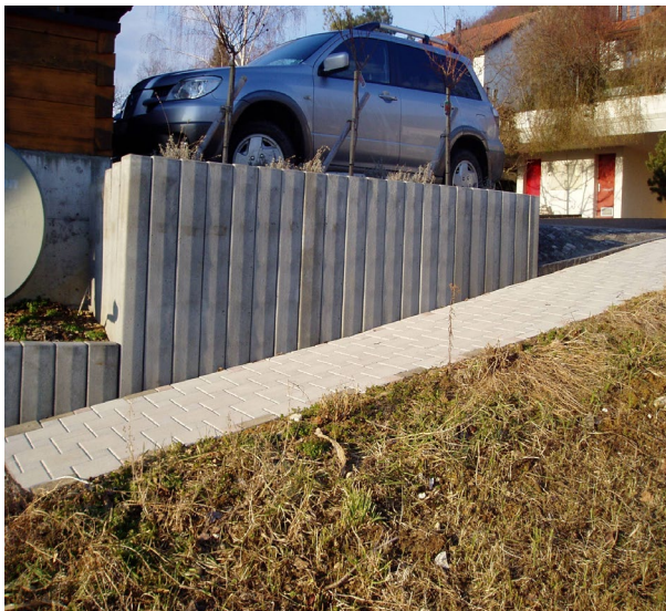
Bild 3: Rechteckige Palisaden als Böschungssicherung
