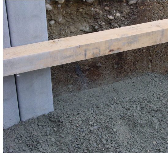
Bild 7: Vorbereitete Sohle mit Richtlatte
