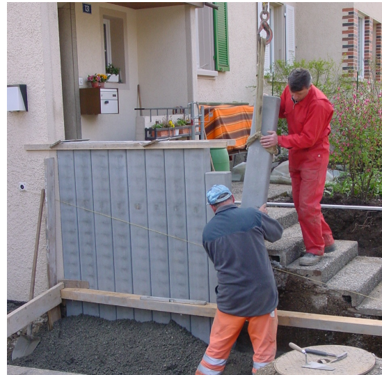
Bild 12: Einbau Palisaden
