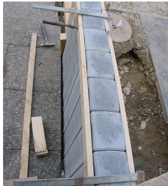
Bild 13: Gesicherte Palisaden
