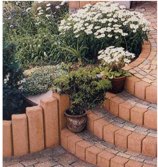
Bild 4: Abstufungen mit rechteckigen Palisaden
