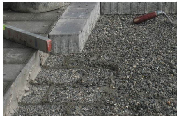
Bild 33: Instandsetzung der Bettungsschicht
