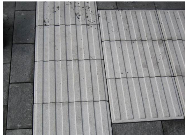
Bild 34: Optimale Fugen bei Steinen H = 8 cm
