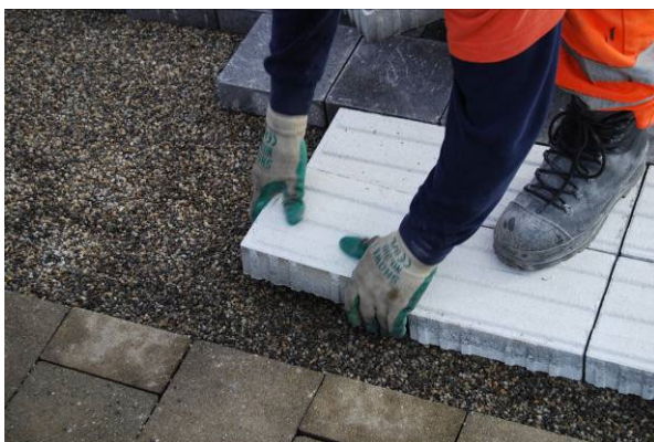
Bild 27: Verlegen von CARENA® Sicherheitsliniensteine H = 6 cm
