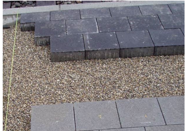
Bild 24: Eingebaute Bettungsschicht
