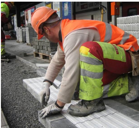
Bild 36: Verlegen der CARENA® Sicherheitsliniensteine H = 8 cm
