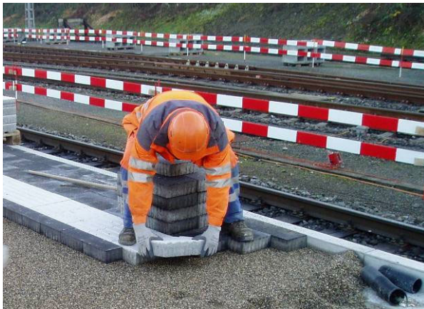
Bild 26: Verlegen von CARENA® Sicherheitsliniensteine H = 8 cm
