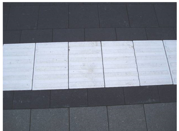
Bild 25: Optimale Fugenbreite
