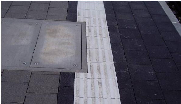
Bild 30: Anpassungen der CARENA® Sicherheitsliniensteine bei Schachtabdeckungen
