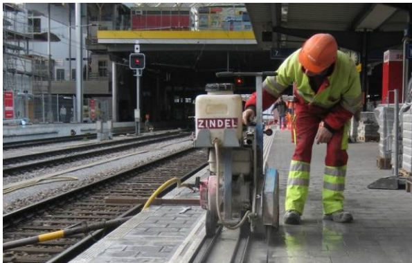
Bild 31: Einsatz einer kleinen Belagsfräse
