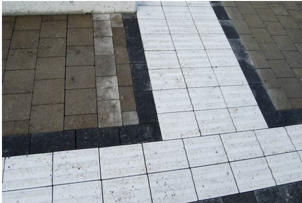
Bild 35: Optimale Fugen bei Steinen H = 6 cm
