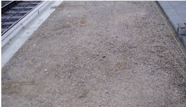
Bild 23: Eingebaute Fundationsschicht
