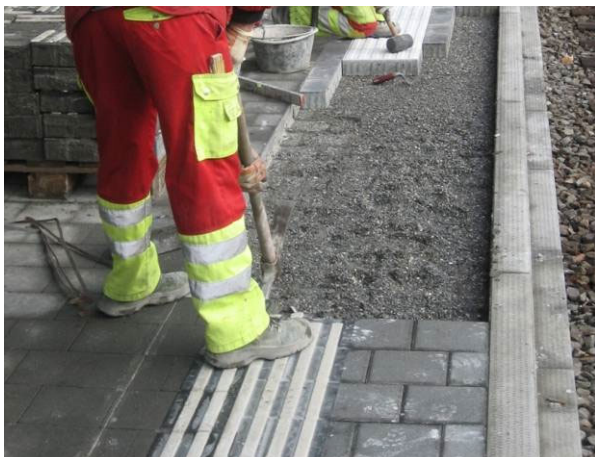
Bild 32: Herausnehmen der restlichen Steine
