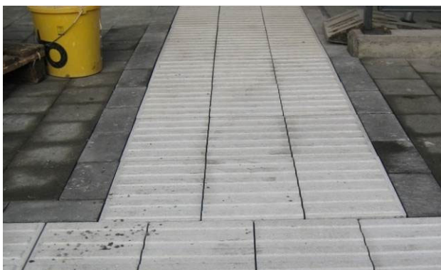
Bild 18: Anschluss Aufmerksamkeitsfelder an Sicherheitslinie
