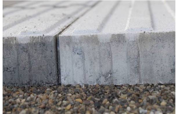
Bild 37: Verlegte CARENA® Sicherheitsliniensteine H = 6 cm
