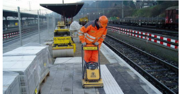
Bild 28: Einsatz eines Flachrüttlers
