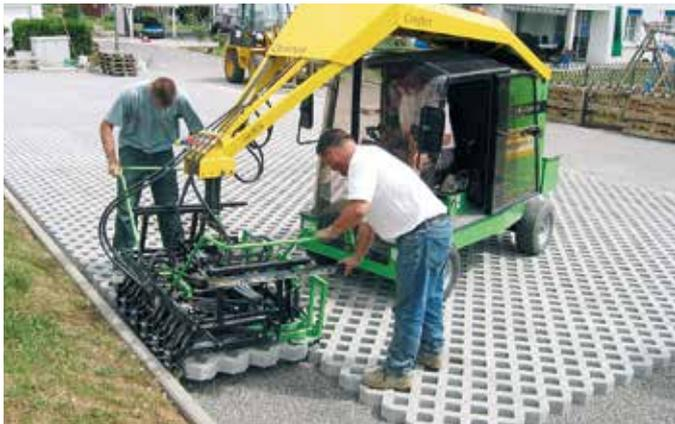
Maschinelles Verlegen mit OPTIMAS-Verlegemaschine
