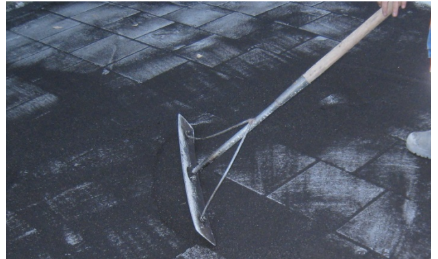
Bild 28: Einbringen des Fugenmaterials von Hand
