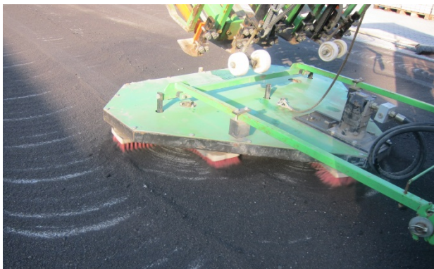
Bild 27: Maschinelles Einbringen des ECOPREC®-Fugenmaterials
