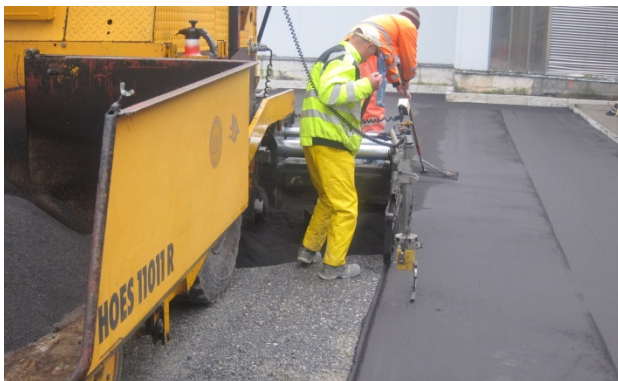
Bild 16: Nahtflanken sind abzukanten
