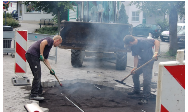
Bild 17: Mischgut muss gesetzt werden
