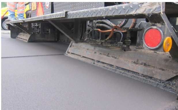
Bild 15: Rüttelbohle darf das Material nur anziehen
