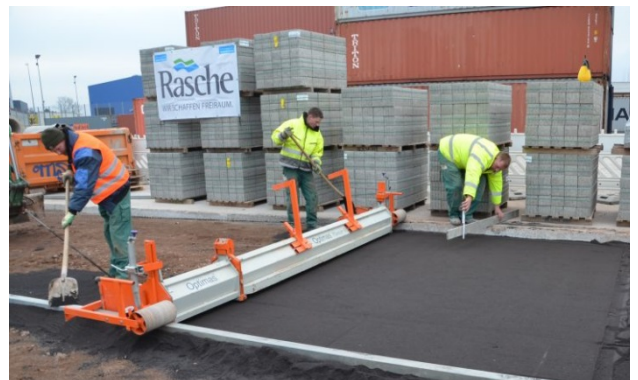
Bild 19: Mischgut abziehen
