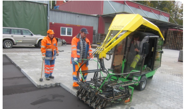
Bild 25: Maschinelle Verlegung
