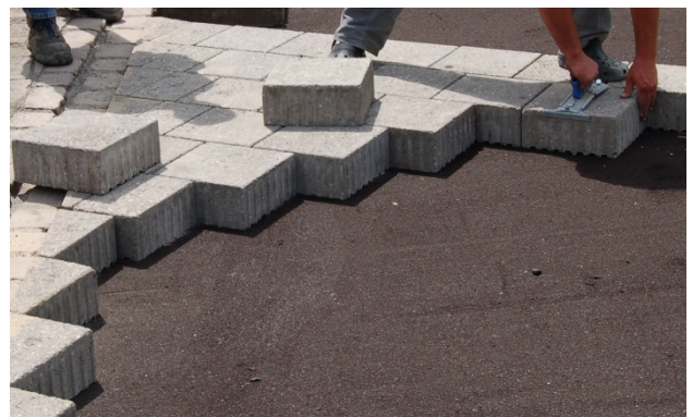
Bild 26: Verlegen von Hand
