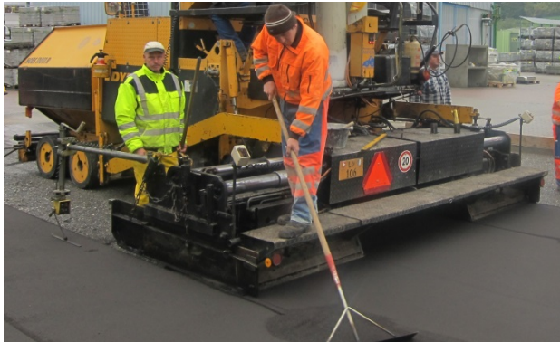
Bild 14: Einbau mit Asphaltfertiger
