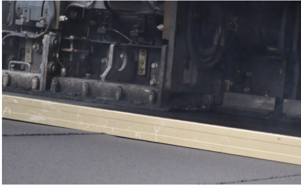
Bild 23: Kontrolle der Ebenheit
