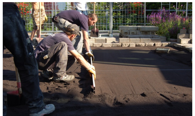
Bild 18: Mischgut abziehen
