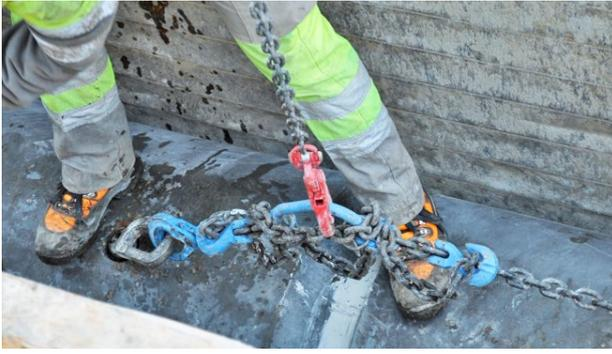
Zusammenziehen der Rohre mit Kettenzuggerät
