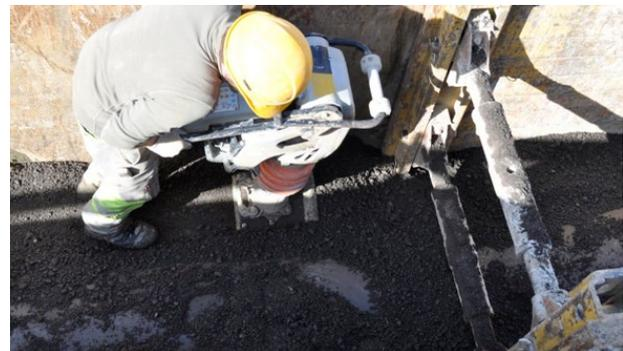
Seitliche Verfüllung und Verdichtung sofort nach dem Versetzen
