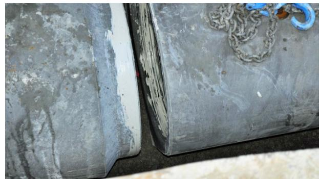
Auftragen des DENSÖ® Gleitmittels kurz vor dem Versetzen
