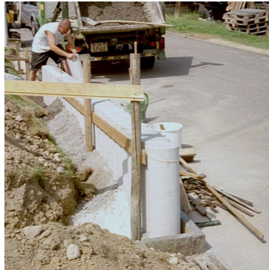
Bild 13: Richtlatte als Verlegehilfe für den Einbau von Palisaden
