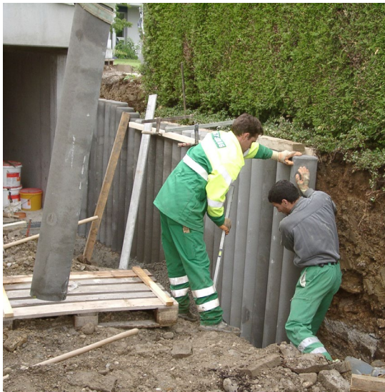
Bild 12: Versetzen und Richten von Palisaden
