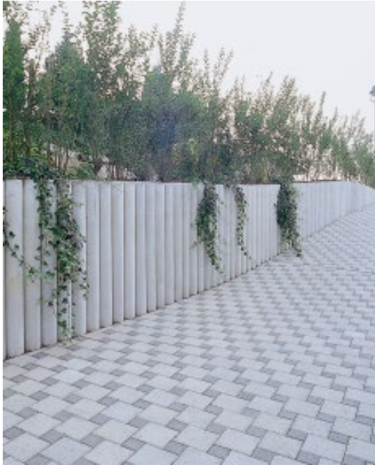
Bild 16: Betonhohlpalisaden als Hangsicherung
