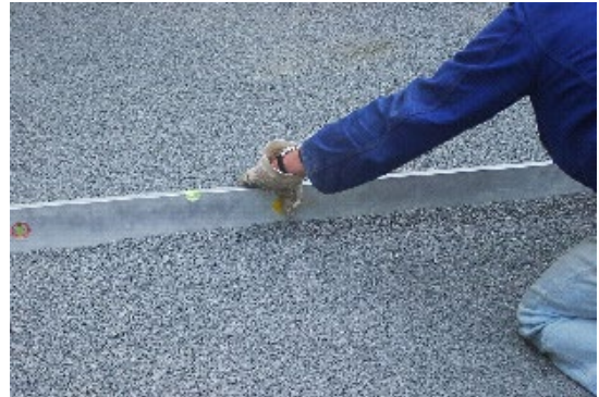
Bild 3: Bettungsschicht abziehen
