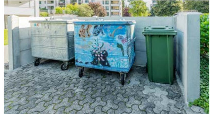
Pfosten zu Betonbretter dienen zusammen mit den Betonbrettern vollkändig als Containereinfassung
