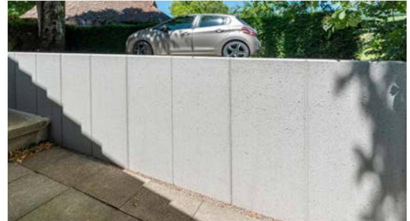
EXACTA® Winkelplatten gestraht zum Überbrücken von Höhenunterschieden
