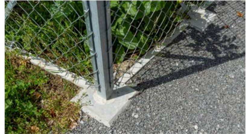
Socket zu Betonbretter gegossen, im Boden eingelassen
