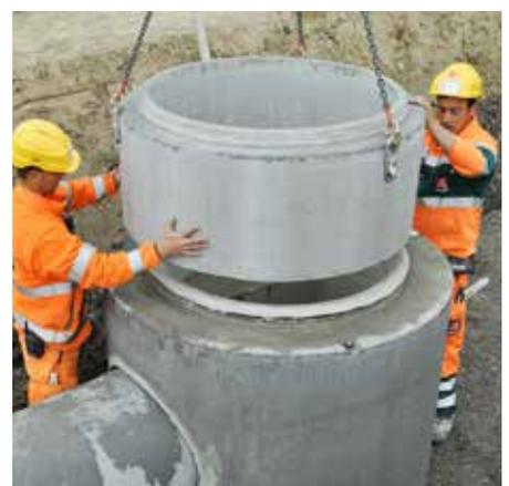
Der Schachtaufbau besteht aus Betonrohren und -konen mit Muffenverbindungen für den Einsatz von Keilgleitdichtungen. Bei niedrigen Überdeckungshöhen werden anstelle von Konen Abdeckplatten eingebaut. Die entsprechenden Belastungsklassen müssen berücksichtigt werden.
