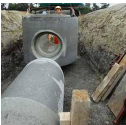
Bevor ein CENTUB® Massschachtunterteil versetzt werden kann, muss eine höhengerechte und horizontale Sohle aus Magerbeton oder einem anderen geeigneten Material hergestellt werden. Je nach Wahl des Rohrmaterials ist ein entsprechendes Passrohr oder abgelängtes Rohr auslaufseitig zu verlegen.
