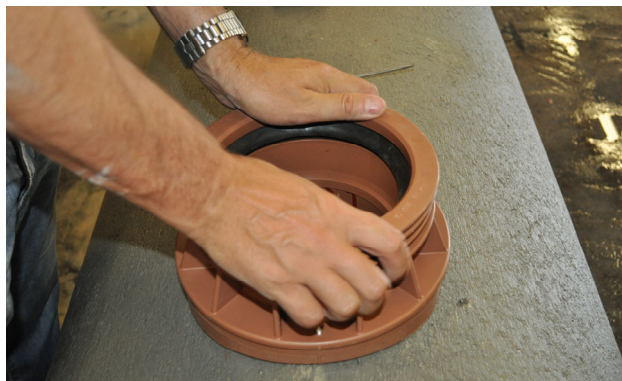
Bild 12: Steckanschlussstück einpressen
