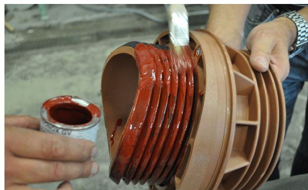
Bild 9: Auftragen von DENSONOX GV auf Dichtungsmanschette
