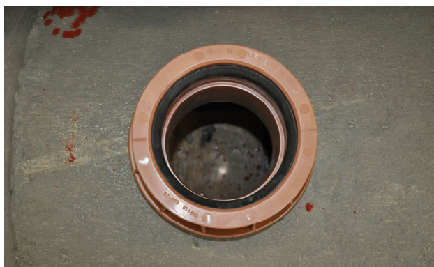
Bild 13: Keilgleitdichtung und Spitzende mit Gleitmittel einschmieren
