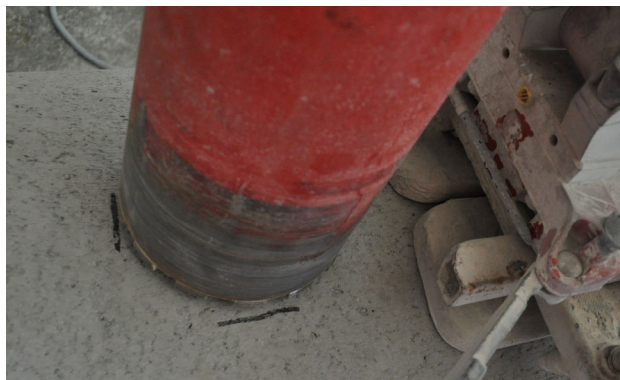
Bild 6: Korrekt montiertes Kernbohrgerät
