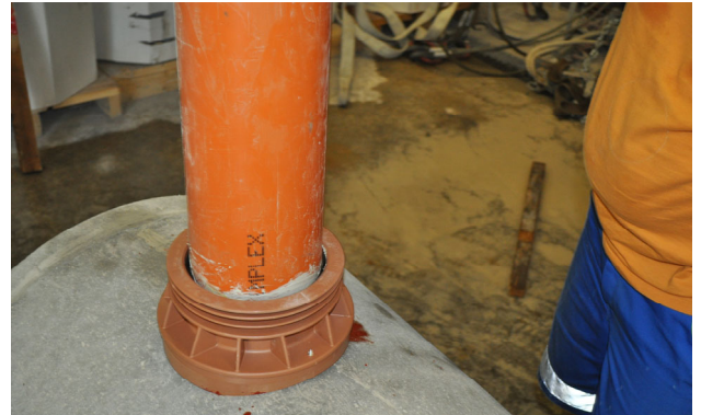
Bild 14: Anschlussrohr anschliessen
