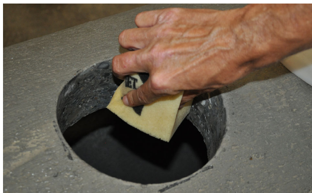
Bild 8: Bohrlochwandung mit Wasser befeuchten
