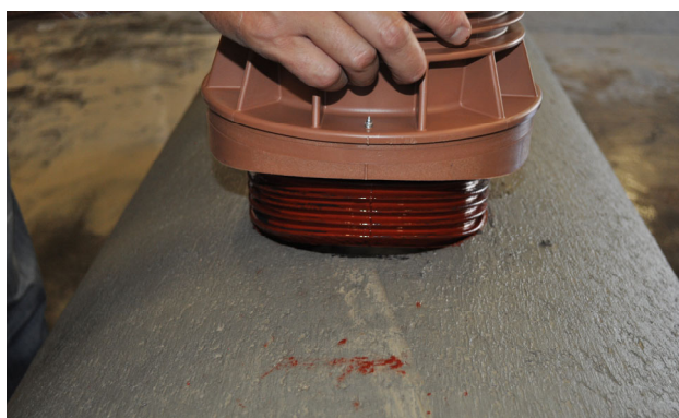
Bild 11: Steckanschlussstück ansetzen, Markierung beachten
