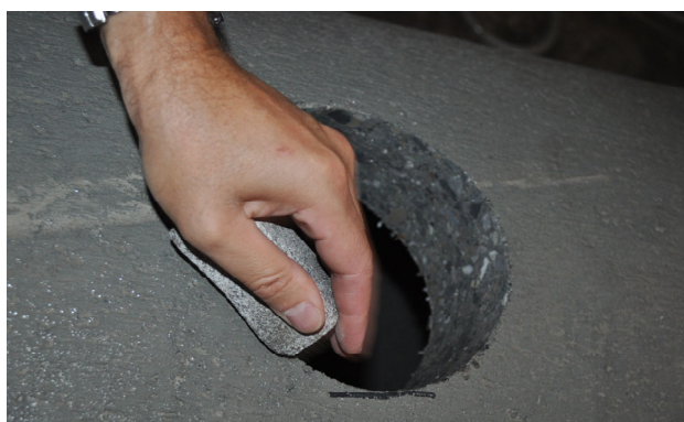
Bild 7: Bohrlochkante abrunden und Bohrloch reinigen
