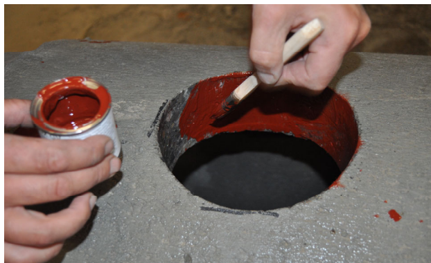
Bild 10: Auftragen von DENSONOX GV auf Bohrlochwandung
