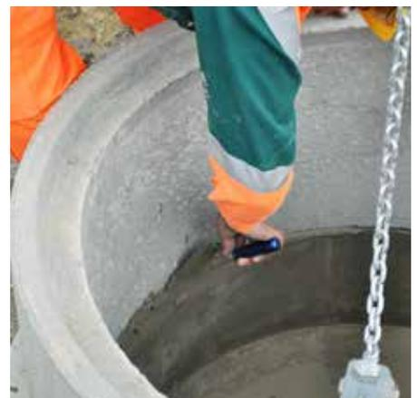
Der Schachtaufbau besteht aus Betonrohren und -konen. Bei niedrigen Überdeckungshöhen werden anstelle von Konen Abdeckplatten eingebaut. Die entsprechenden Belastungsklassen müssen berücksichtigt werden. Für die Ausführung von wasserdichten Verbindungen ist ein geeignetes Dichtungsmaterial zu verwenden.
