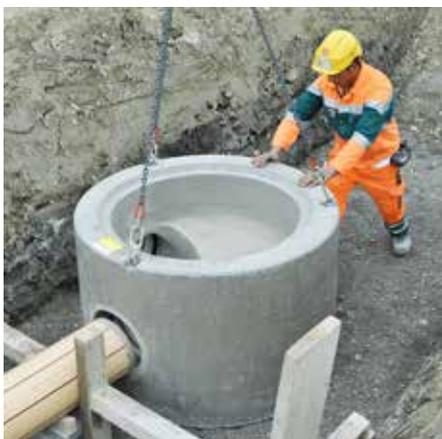
Bevor ein CREMA Massschachtunterteil versetzt werden kann, muss eine höhengerechte und horizontale Sohle aus Magerbeton oder einem anderen geeigneten Material hergestellt werden. Je nach Wahl des Rohrmaterials ist ein entsprechendes Passrohr oder abgelängtes Rohr auslaufseitig zu verlegen.
