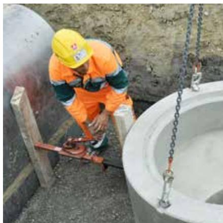
Die Dichtringe sind mit Gleitmittel in genügender Menge einzuschmieren. Das Unterteil sollte während der Versetzung nicht vollständig vom Hebegerät gelöst werden. Der Zusammenzug kann mit einem Zugerät oder einer Stockwinde ausgeführt werden. Die Baggerschaufel ist dafür ungeeignet.
