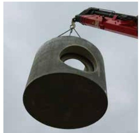
Mit den werkseitig eingebauten Kugelkopftragankern und dem entsprechenden Gehänge können die Schachtbauerteile schnell und sicher am gewünschten Punkt auf der Baustelle abgeladen werden. Unsere versierten Chauffeure sind dafür speziell ausgebildet.
