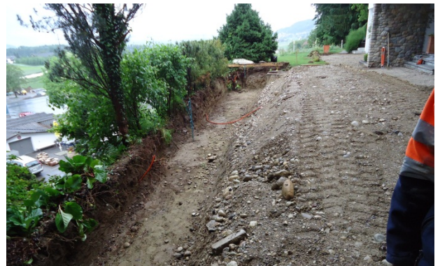
Bild 22: Erstellen der Sauberkeitsschicht
