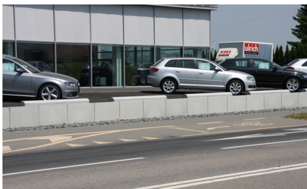
Bild 1: Winkelplatten als Böschungssicherung
