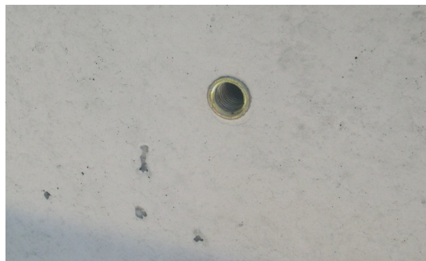
Bild 20: Werkseitig eingebaute Versetzhülse
