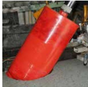
Kreisloch mit Diamant-Bohrkrone im gewünschten Winkel und zentrisch zur Rohrachse bohren.
