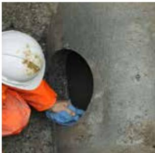
Bohrlochwandung von Schmutz bzw. Staub befreien.
