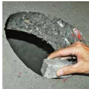
Bohrlochwandung von Schmutz bzw. Staub befreien.
