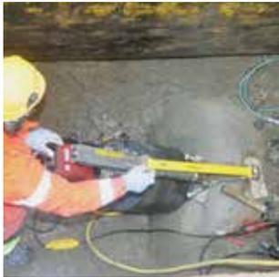
Kreisloch mit Diamant-Bohrkrone rechtwinklig und zentrisch zur Rohrachse bohren.
