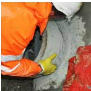
CENTUB® Klebeanschlussstück mit einer Drehbewegung in das Bohrloch einführen.
