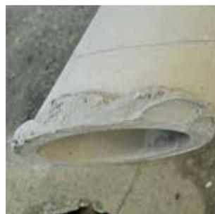
CENTUB® Universalanschlussstück mit einer Drehbewegung in das Bohrloch einführen und richten.
