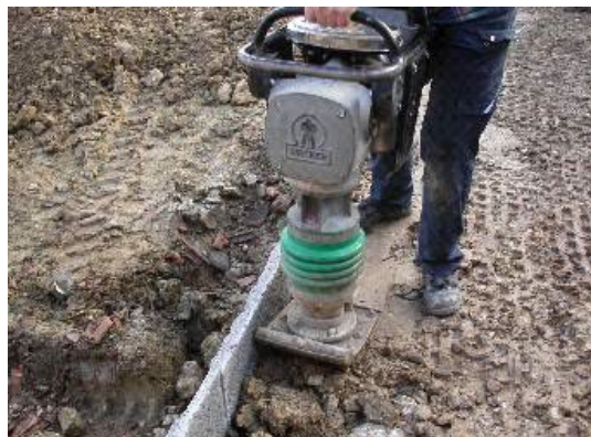
Bild 22: Verdichten mit Vibrostamper
