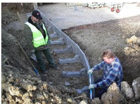
Bild 19: Versetzen der ersten Lage
