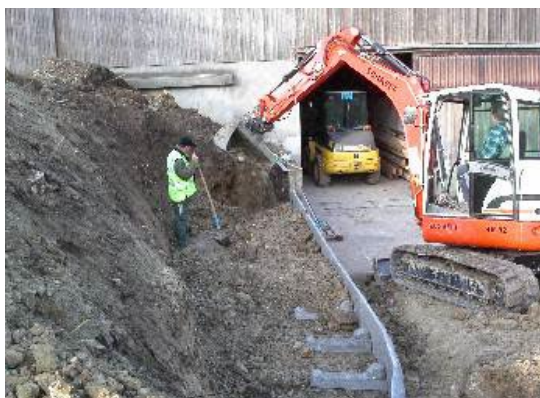
Bild 20: Hinterfüllen der ersten 20 cm
