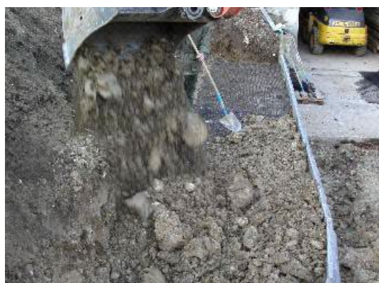
Bild 25: Hinterfüllen der zweiten 20 cm
