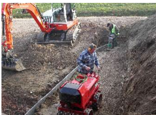
Bild 21: Verdichten mit Schaffusswalze
