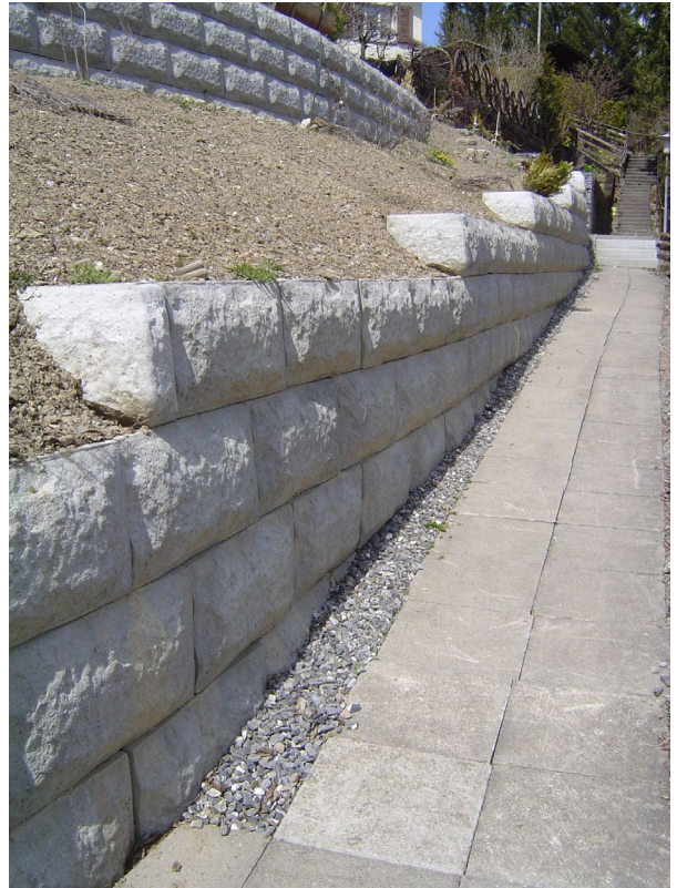
Bild 47: seitlicher Abschluss der Abtreppungen mit Ecksteine
