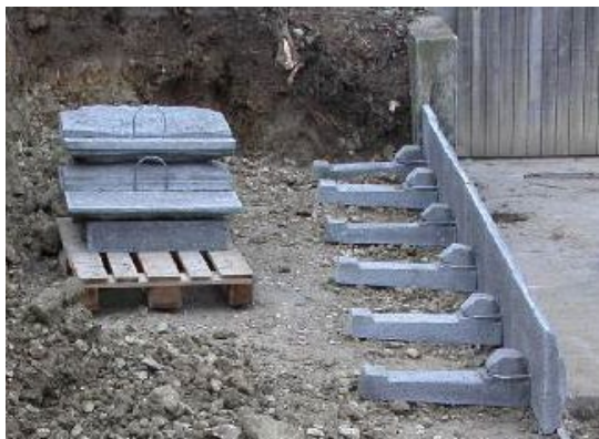
Bild 18: Verlegte Frontplatte mit Normalanker
