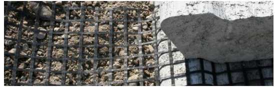
Bild 36: Eingeklemmtes Geogitter
