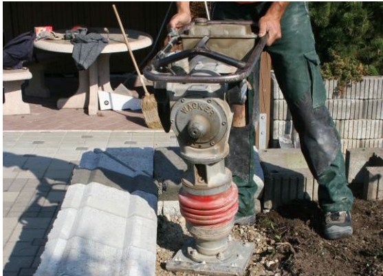
Bild 33: Verdichten der Hinterfüllung
