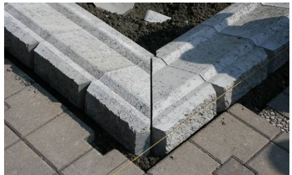
Bild 32: Bearbeitete Steine für die Eckausbildung
