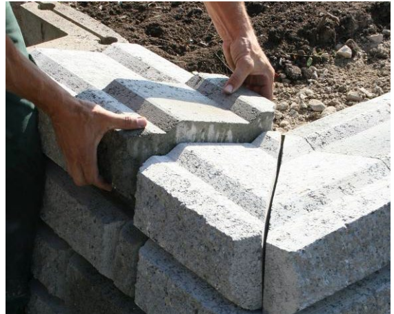
Bild 31: Versetzen der weiteren Steinreihen
