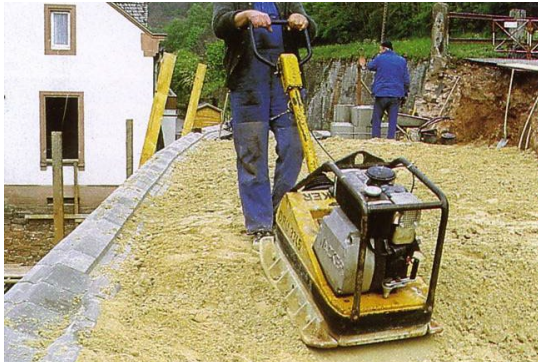
Bild 38: Verdichten über Geogittern
