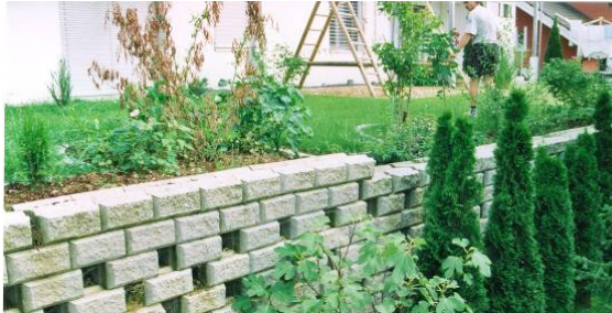
Bild 13: Offene und geschlossene Bauweise abwechselnd
