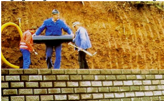
Bild 34: Auslegen der Geogitter
