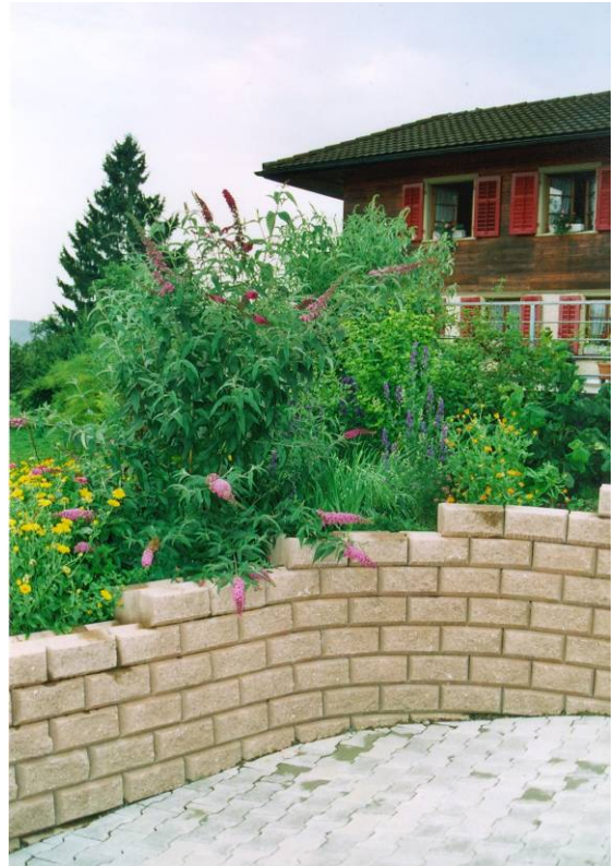
Bild 21: Kurvenbildung in geschlossener Bauweise
