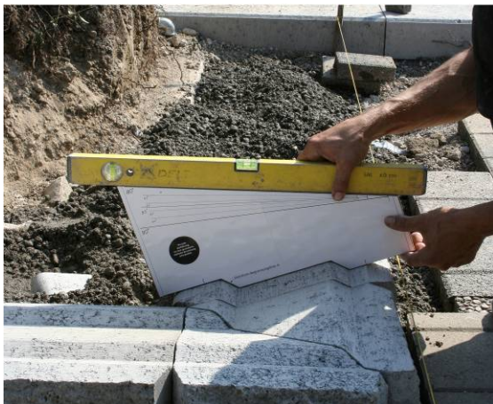
Bild 30: Anwendung der Kartonschablone
