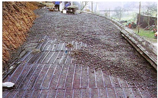
Bild 37: Verlegte Geogitter
