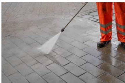
Utiliser le nettoyeur à haute pression à une distance suffisante.
