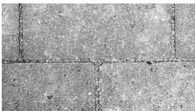
Wirksame Pflasterdecke durch funktionsfähige Fugen
