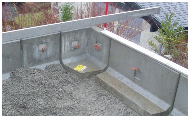
Bild 38: Versetztes Eckelement
