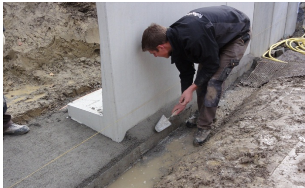
Bild 37: Erstellen der Fundamentnocken
