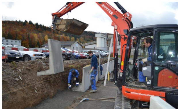
Bild 35: Versetzen der Winkelplatten
