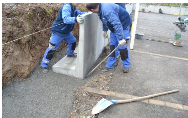
Bild 36: Richten der Winkelplatte
