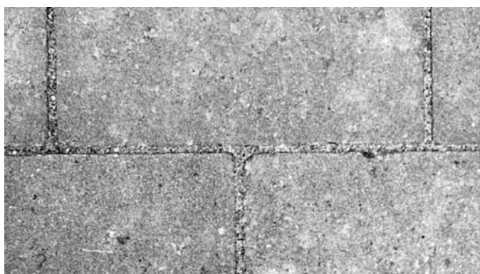
Wirksame Pflasterdecke durch funktionsfähige Fugen
