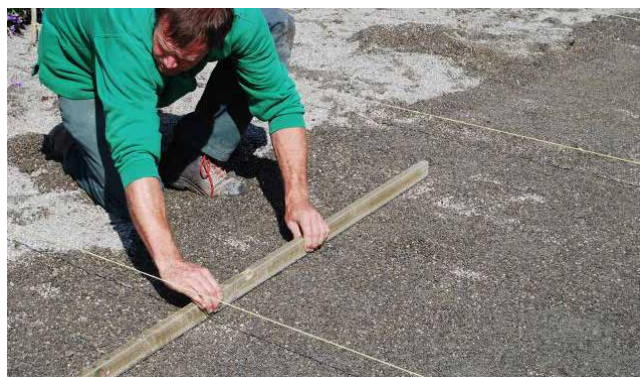
Nivellement du lit de pose
