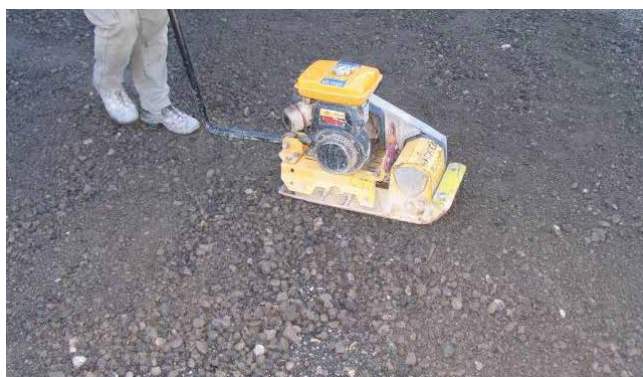
Compactage de la couche de fondation
