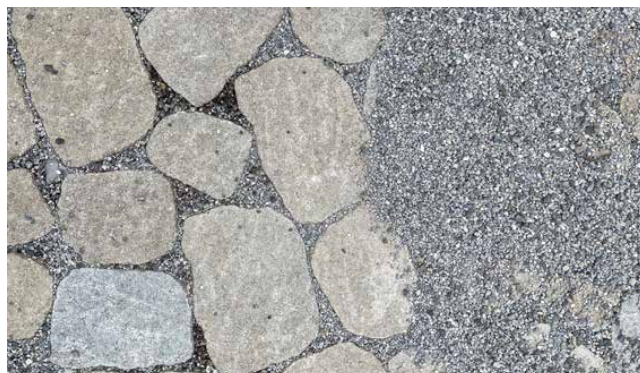
Sablage/gravillonnage des joints
