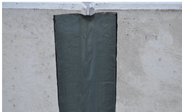
Bild 27: Abdichten der Fugen
