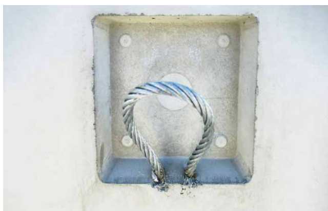
Illustration 24 : boucles de manutention montées en usine
