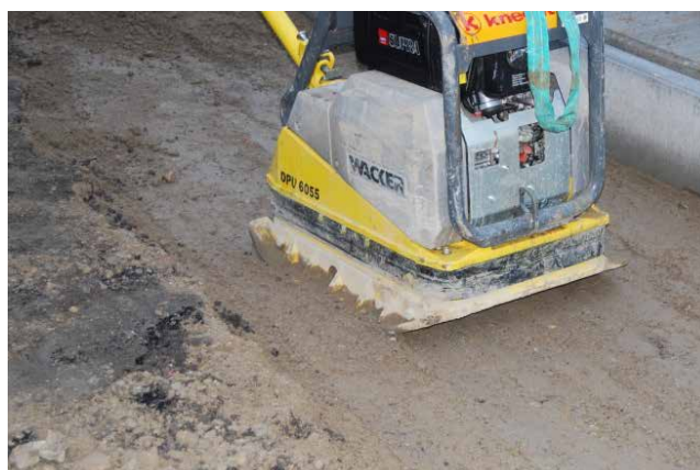
Illustration 35 : compactage avec machine légère uniquement
