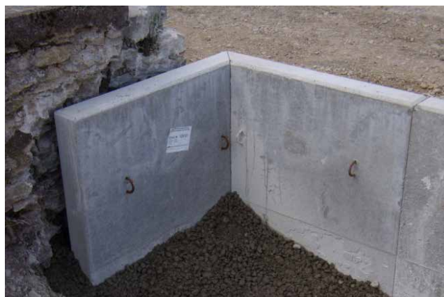
Illustration 31 : éléments d'angle posés
