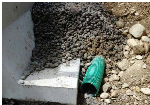
Illustration 28 : mise en place d'une conduite de drainage avec lit de drainage
