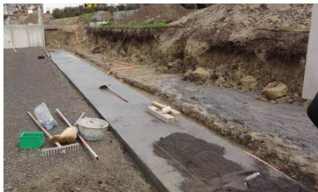
Illustration 27 : semelle filante réalisée
