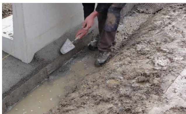
Illustration 30 : réalisation de l'ergot de fondation
