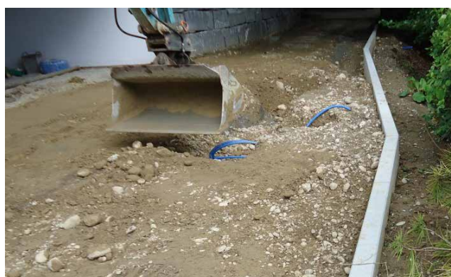
Illustration 34 : mise en place d'un remblai adapté, en pose par couches
