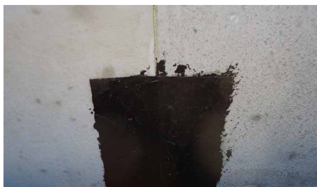
Illustration 33 : étanchéification des joints
