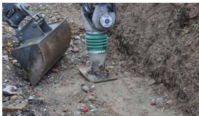
Illustration 26 : réalisation de la couche de propreté
