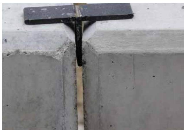
Illustration 32 : joint optimal après la pose
