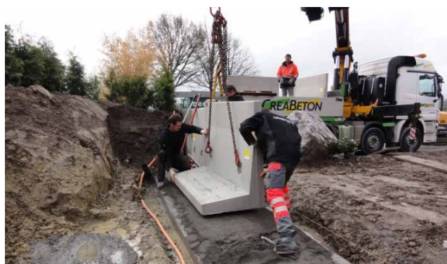
Illustration 29 : pose des éléments en équerre sur une semelle filante
