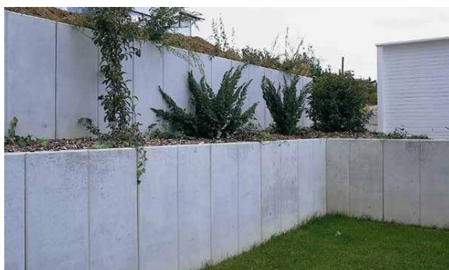
Illustration 1 : éléments en équerre EXACTA® comme consolidation de talus
