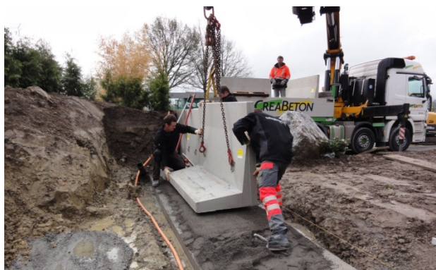
Bild 29: Versetzen der Winkelplatte auf ein Streifenfundament
