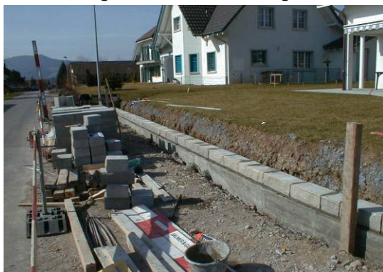
Bild 23: Versetzte erste Steinreihe in Betonfundament
