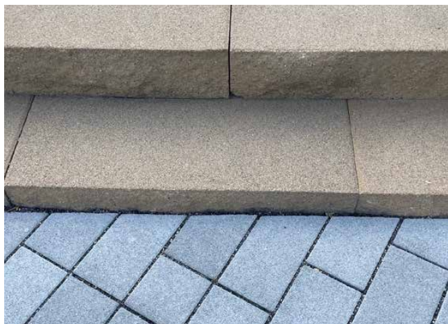
Illustration 9 : fraisage et pose de demi-pavés de 14 x 18 cm
