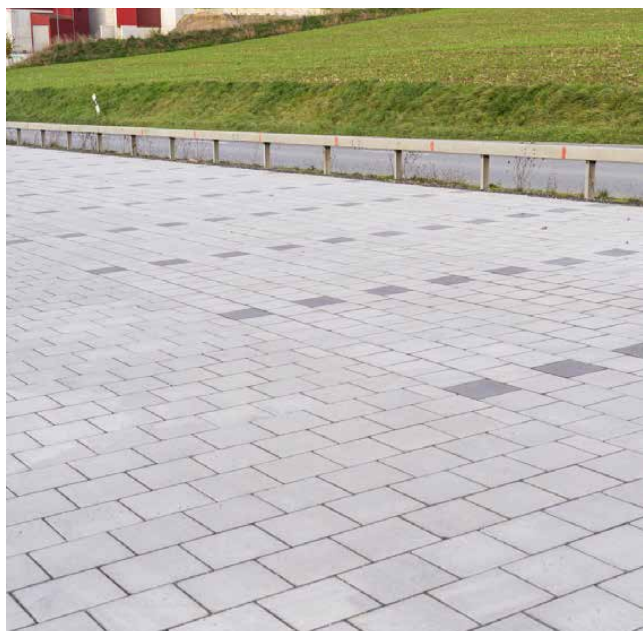
Illustration 1 : aire de stationnement réalisée avec des pavés écologiques CLIMA STONE Drain
