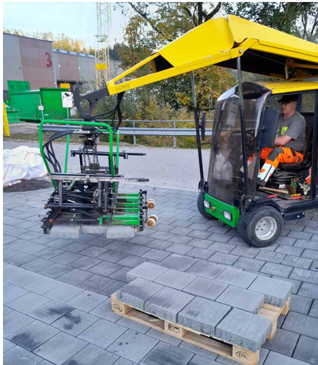
Illustration 8 : les pavés CLIMA STONE Drain peuvent être posés mécaniquement
