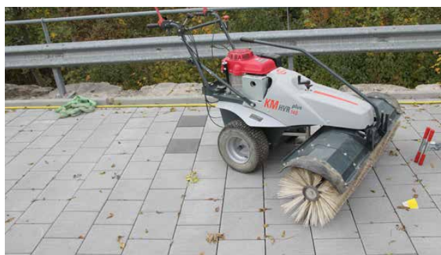
Illustration 7 : sablage des joints
