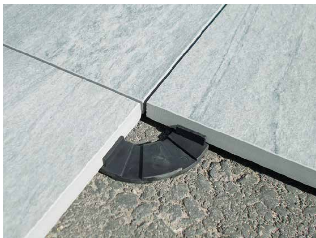
Figure 11 : pose de dalles de jardin en grès cérame sur des anneaux d'appuis.
