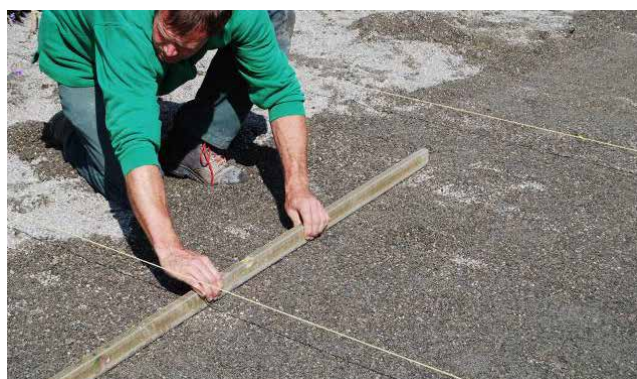
Réglage du lit de pose
