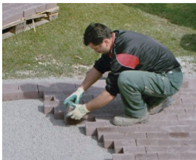
Bild 14: Verlegung der Steine von Hand
