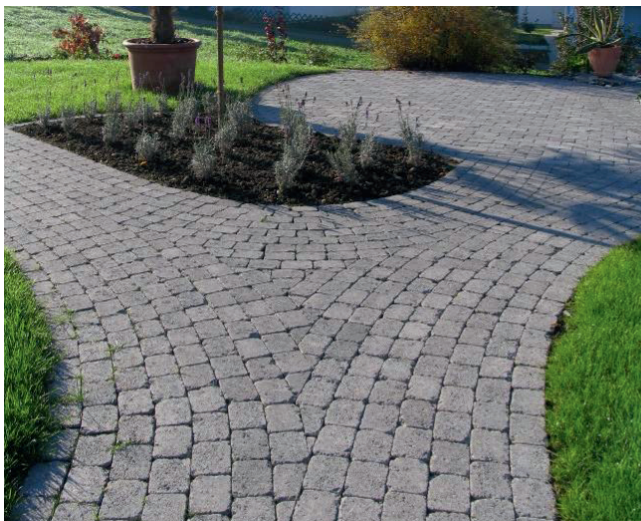
Bild 20: Pflasterfläche mit Passsteinen
