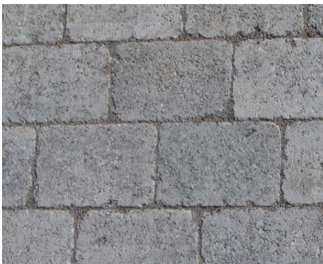
Bild 13: Optimale Fugen bei TEGULA® Pflastersteinen
