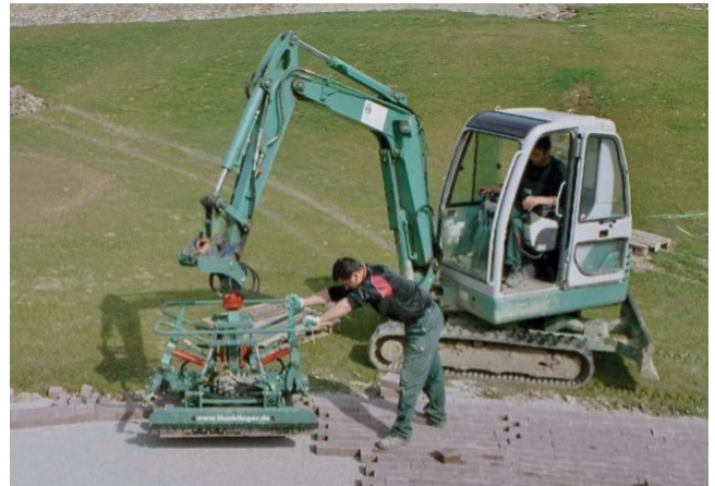
Bild 17: Verlegemaschine im Einsatz
