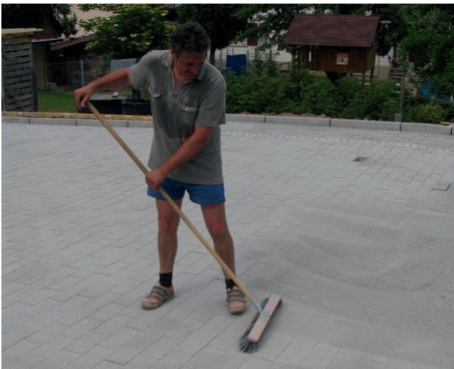
Bild 16: Einsanden der Fugen
