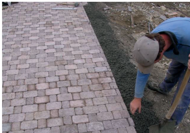
Bild 22: Erstellen des Randabschlusses
