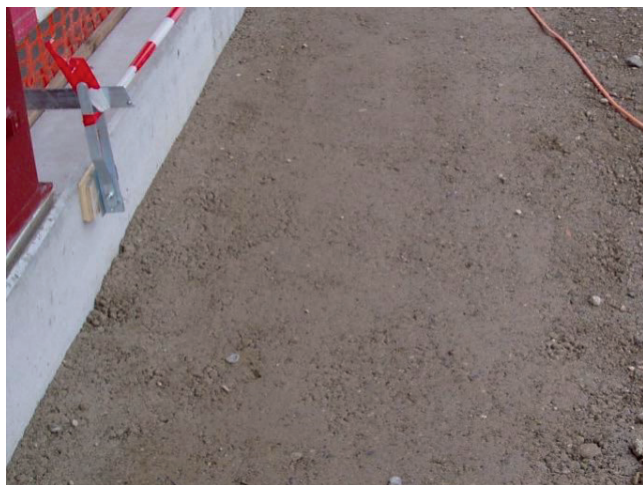
Bild 11: Eingebaute verdichtete Fundationsschicht
