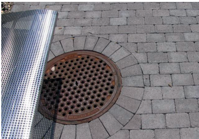
Bild 21: Anpassung bei Schachtabdeckung
