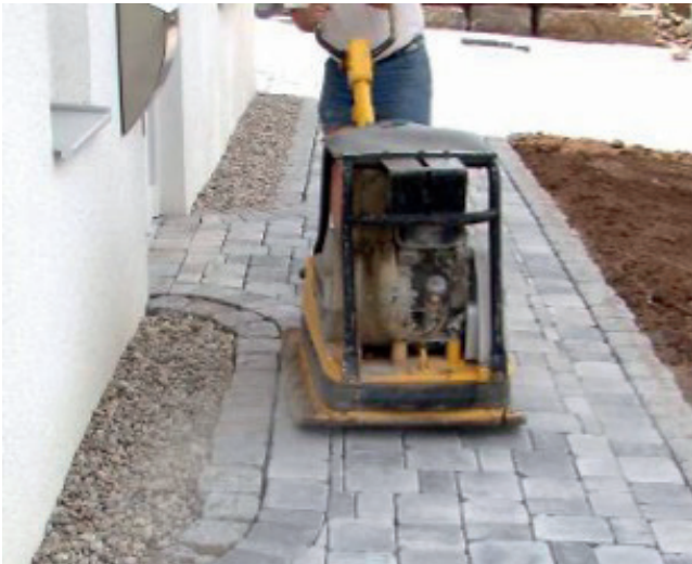
Bild 15: Abrütteln der Pflasterfläche
