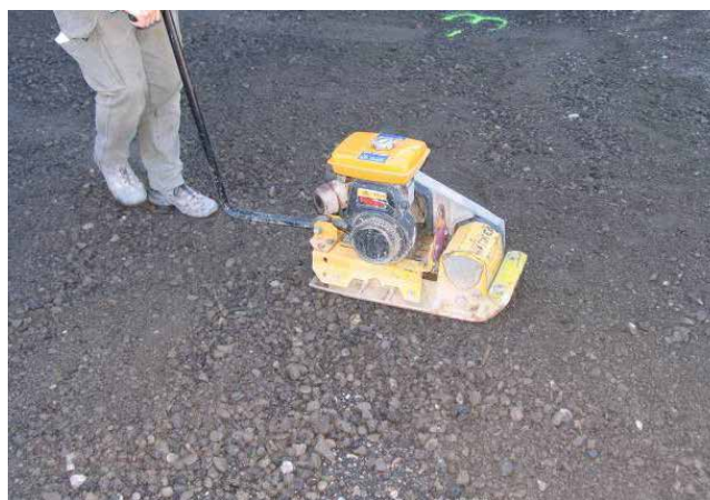
Compactage de la couche de fondation
