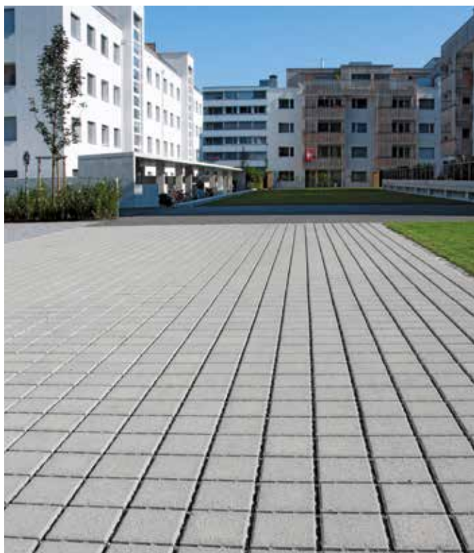
Parkfläche mit SPLITT Ökostein
