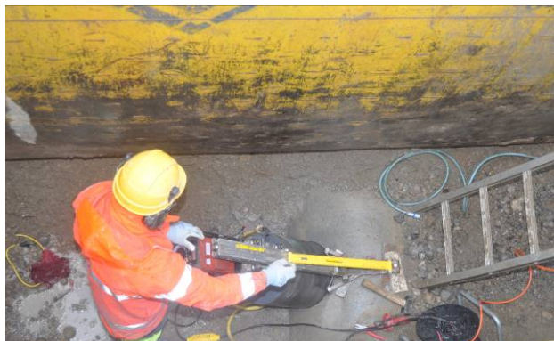
Bild 6: Korrekt montiertes Kernbohrgerät
