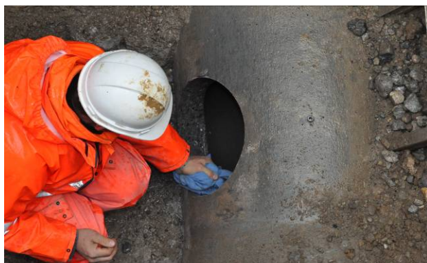
Bild 7: Bohrloch reinigen
