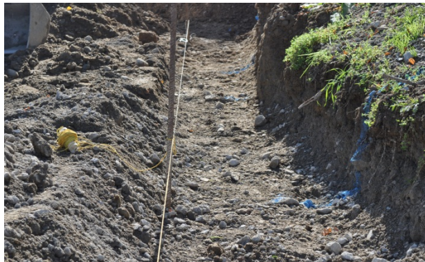
Bild 19: Aushub auf Frosttiefe
