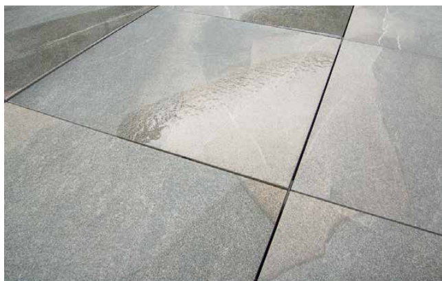
Figure 5 : Eau dans les bords en raison de la tension superficielle
