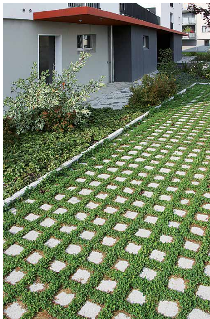
Parkfläche mit CLASSIC® Rasenfuge
